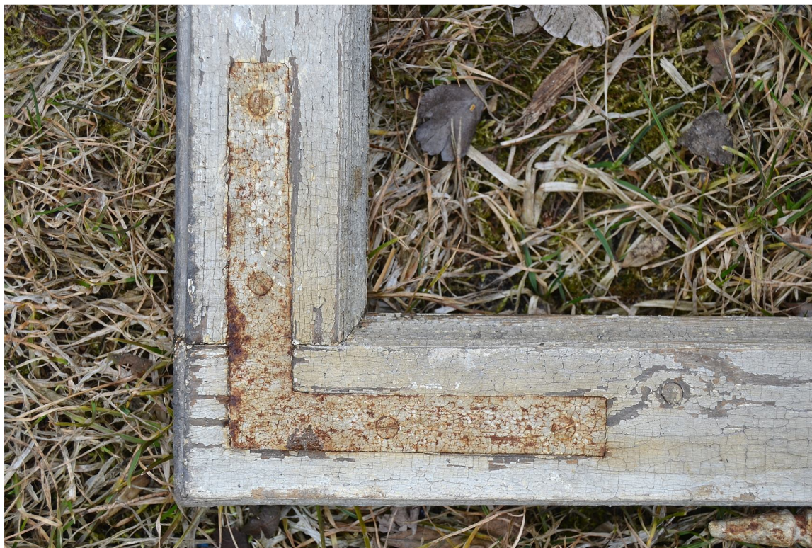
Il. 21 Dusocin – Budynek mieszkalny w zabytkowej zagrodzie wiejskiej – stolarka okienna - widok na fragment skrzydła okiennego z narożnikiem okiennym wpuszczanym
