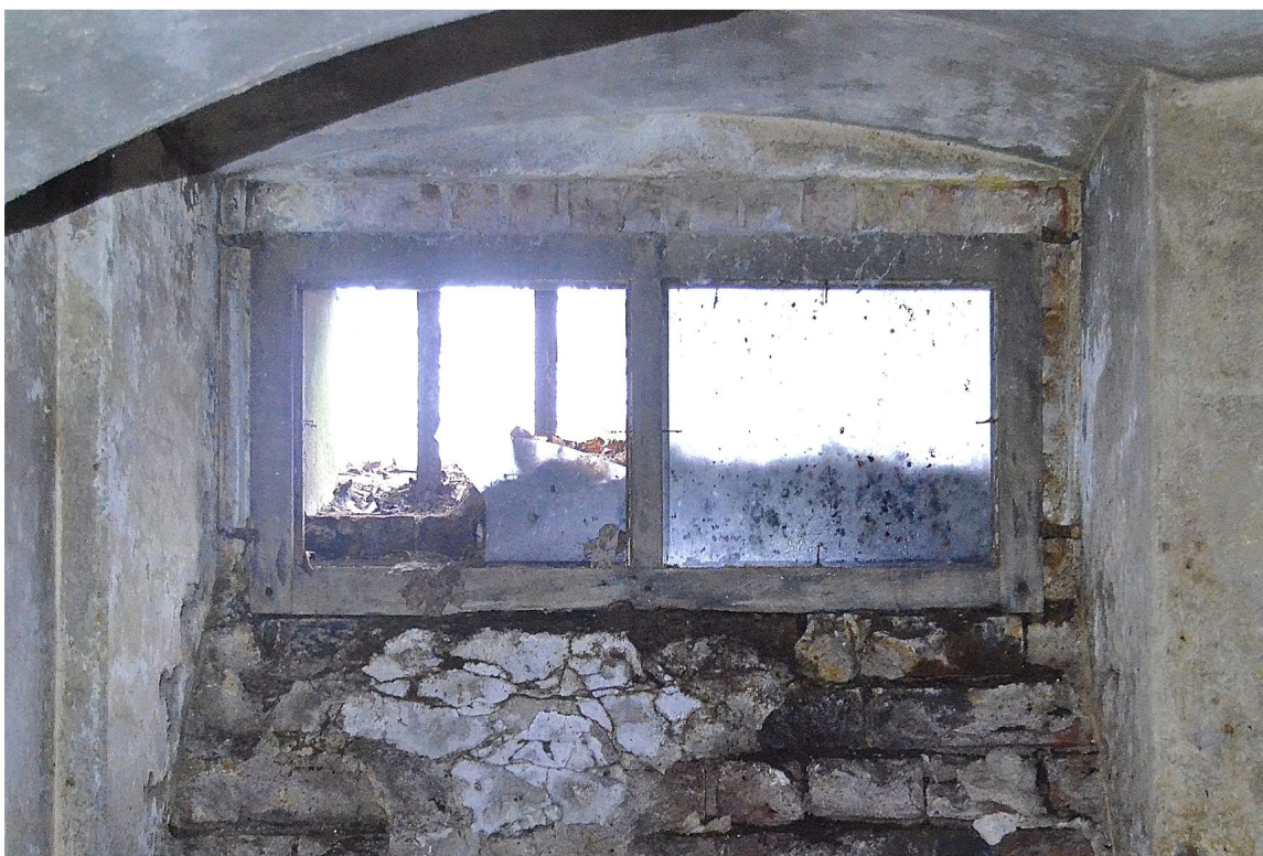
Il. 2 Dusocin – Budynek mieszkalny w zabytkowej zagrodzie wiejskiej – stolarka okienna - piwnica – widok na wtórną stolarkę okienną, bez obokni, stałą
