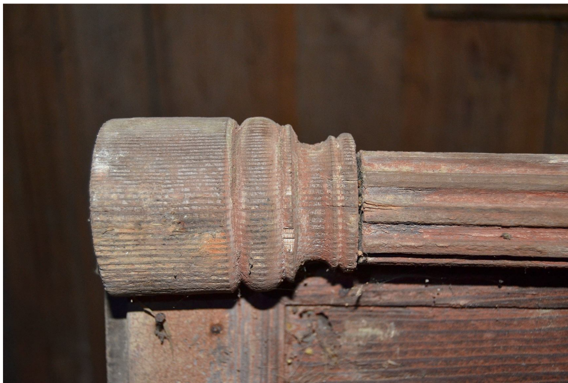
Il. 71 Dusocin – Budynek mieszkalny w zabytkowej zagrodzie wiejskiej – stolarka drzwiowa - drzwi wejściowe (D/1) – widok na fragment listwy przymykowej zewnętrznej zakończonej główką fot. Ewa Bożejewicz 2018 r.
