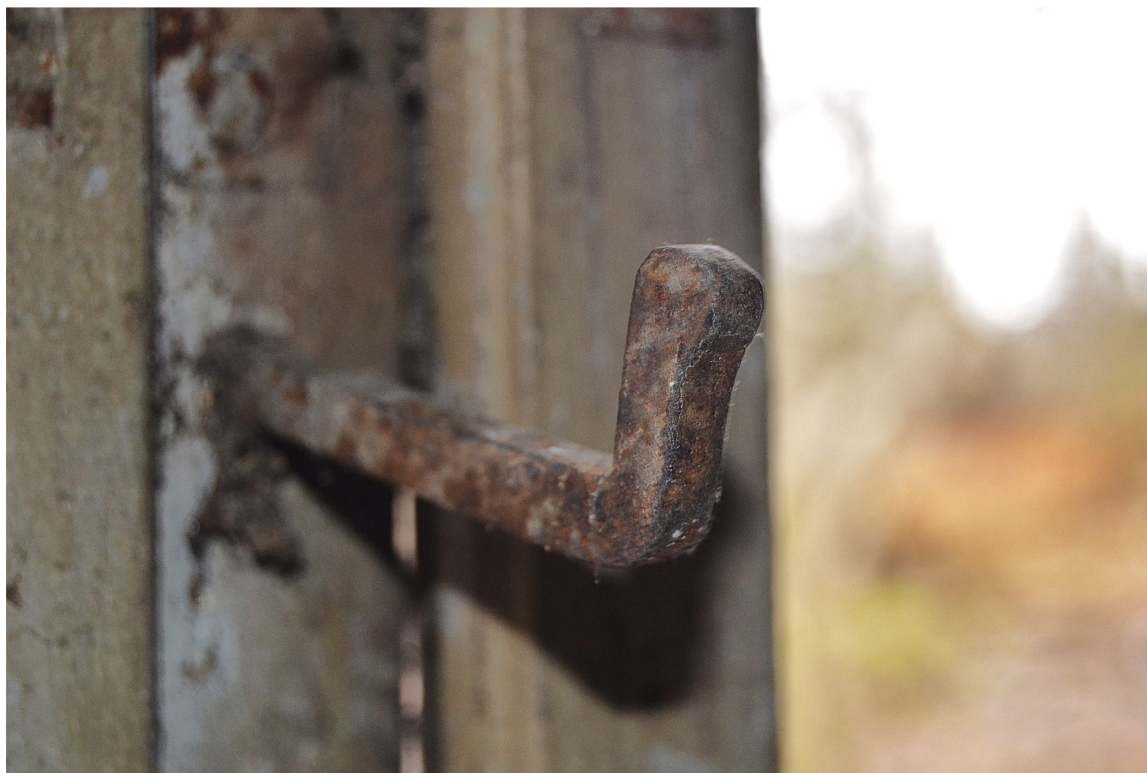
Il. 51 Dusocin – Budynek mieszkalny w zabytkowej zagrodzie wiejskiej – stolarka okienna - okiennice – widok na pierwotny hak zakrętki dźwigniowej, zamocowany do słupka okna
