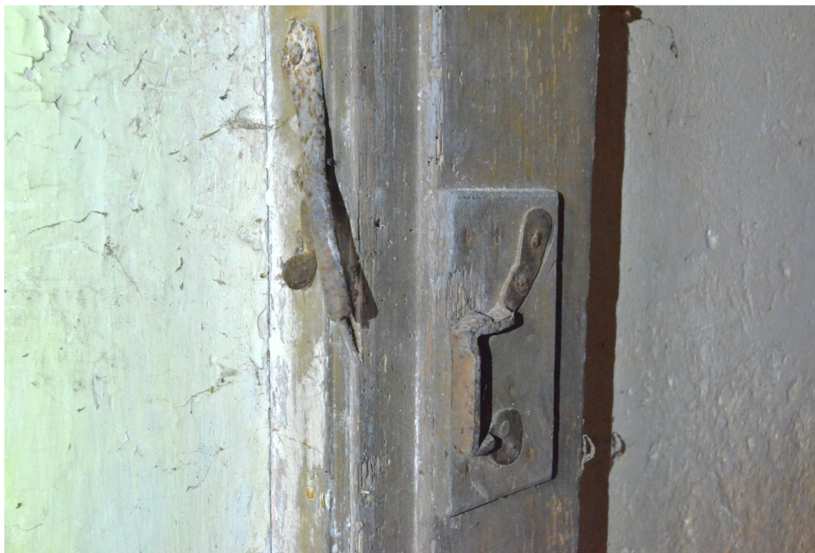
Il. 133 Dusocin – Budynek mieszkalny w zabytkowej zagrodzie wiejskiej – stolarka drzwiowa - drzwi wewnętrzne TYP III – widok na pierwotny zaczep zamka skrzynkowego drzwi (D/11) fot. Ewa Bożejewicz 2018 r.
