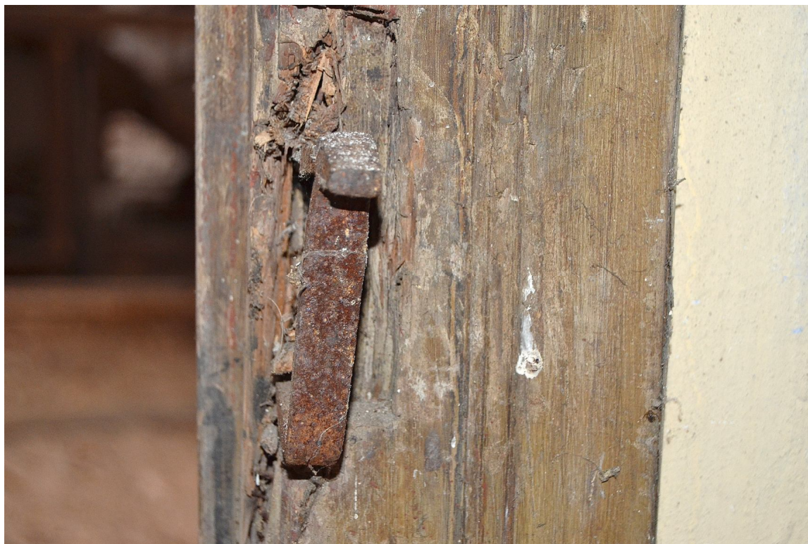
Il. 136 Dusocin – Budynek mieszkalny w zabytkowej zagrodzie wiejskiej – stolarka drzwiowa - drzwi wewnętrzne TYP III – widok na zaczep zamka skrzynkowego pierwotnych drzwi poddasze - D/2) fot. Ewa Bożejewicz 2018 r.
