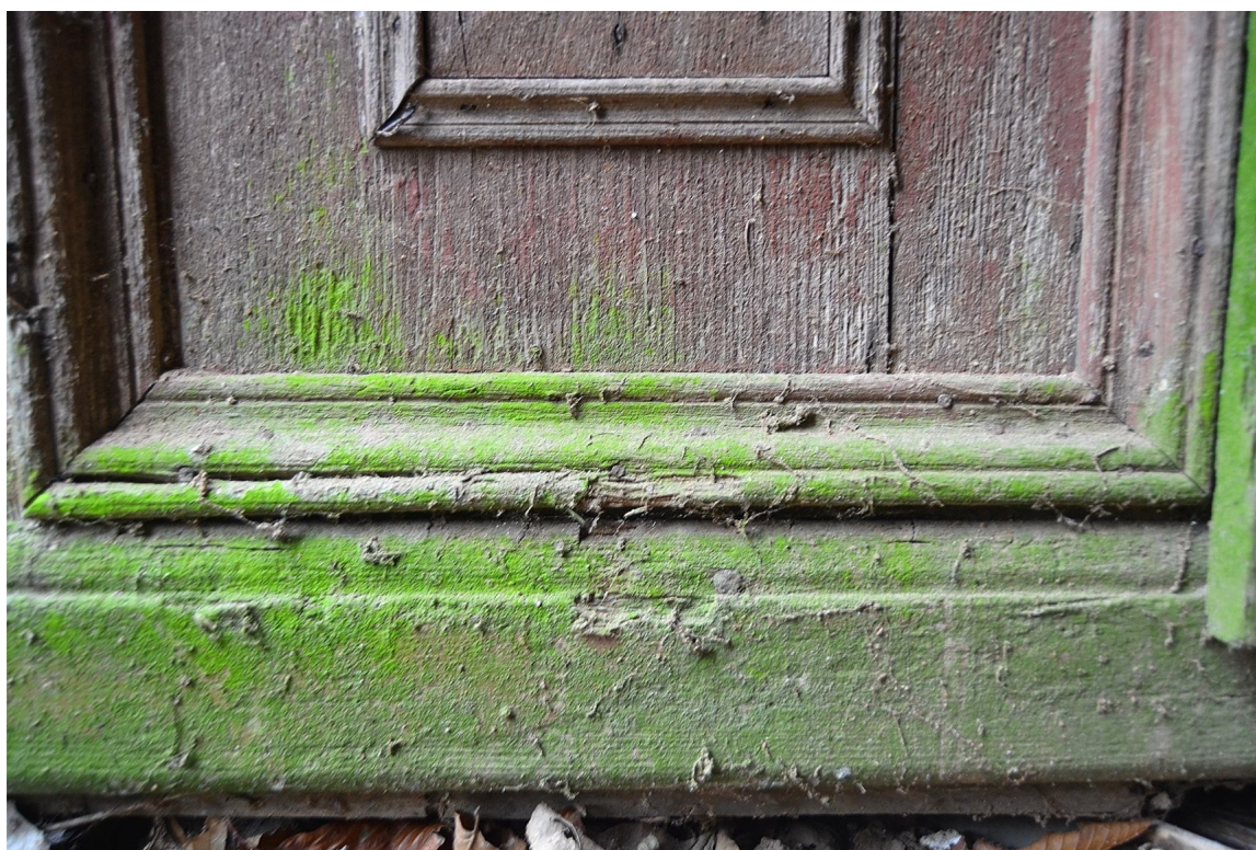
Il. 104 Dusocin – Budynek mieszkalny w zabytkowej zagrodzie wiejskiej – stolarka drzwiowa - drzwi wejściowe tylne (D/3) – widok na fragment dolnej płyciny oraz listwę progową skrzydła fot. Ewa Bożejewicz 2018 r.
