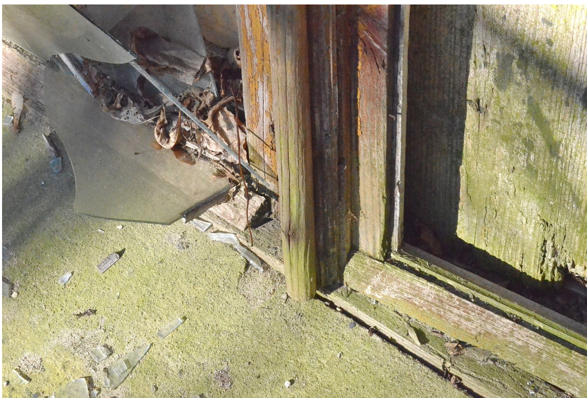
Il. 8 Dusocin – Budynek mieszkalny w zabytkowej zagrodzie wiejskiej – stolarka okienna - parter – widok na fragment pierwotnej stolarki okiennej oraz parapet zewnętrzny
