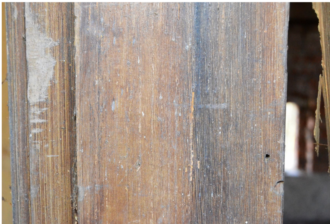
Il. 137 Dusocin – Budynek mieszkalny w zabytkowej zagrodzie wiejskiej – stolarka drzwiowa - drzwi wewnętrzne TYP III – widok na mazerowany stojak ościeżnicy z opaskami na poddaszu (D/2) fot. Ewa Bożejewicz 2018 r.
