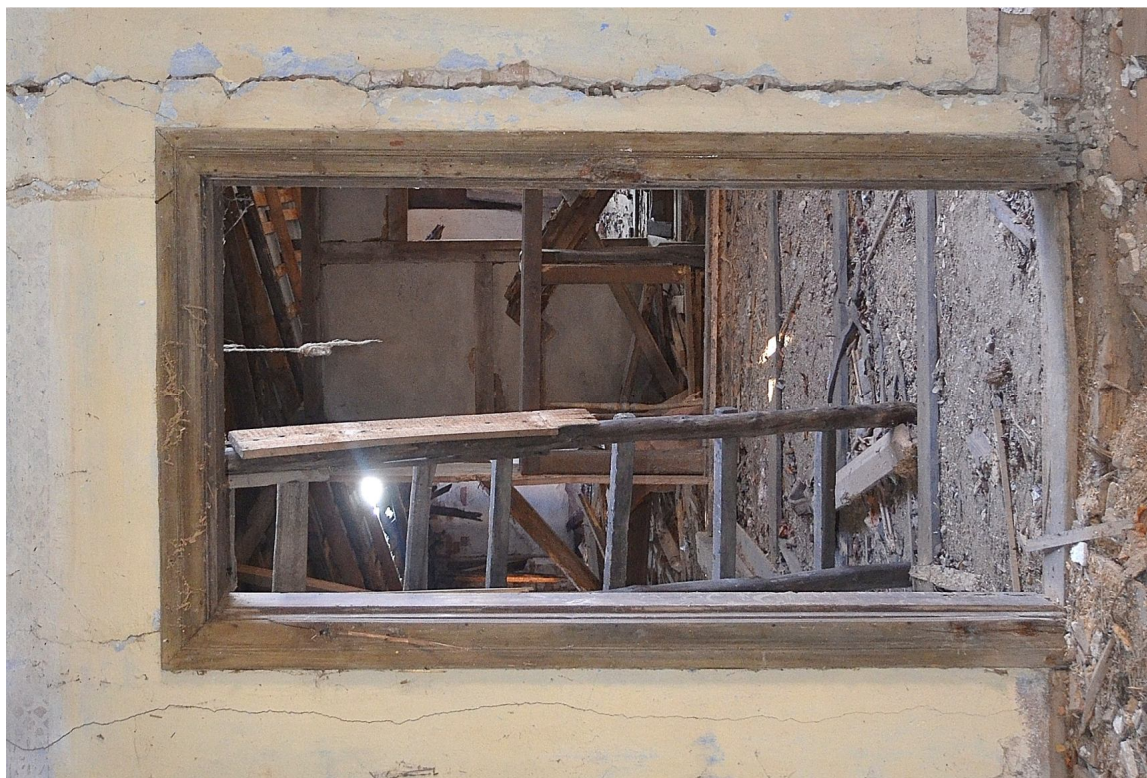
Il. 135 Dusocin – Budynek mieszkalny w zabytkowej zagrodzie wiejskiej – stolarka drzwiowa - drzwi wewnętrzne TYP III – widok na pierwotną ościeżnicę z opaskami drzwi na poddaszu (D/2) fot. Ewa Bożejewicz 2018 r.
