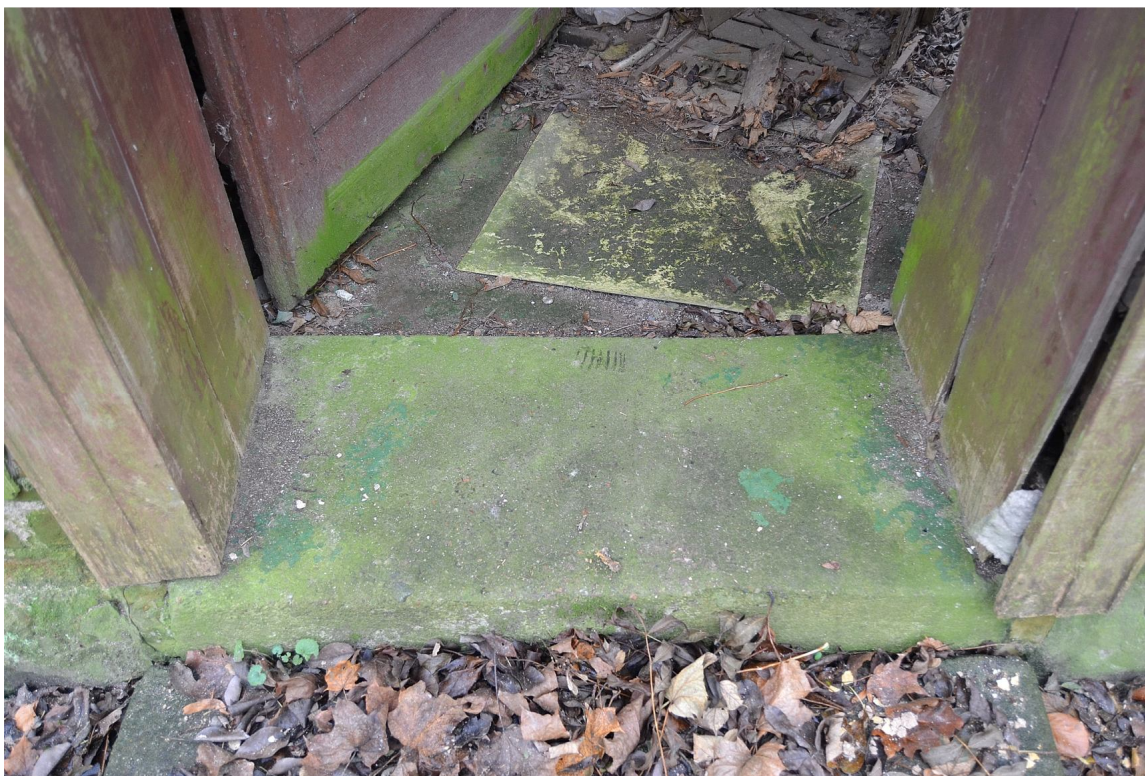
Il. 89 Dusocin – Budynek mieszkalny w zabytkowej zagrodzie wiejskiej – stolarka drzwiowa - drzwi wejściowe boczne (D/2) – widok na wtórny próg i stojaki odrzwi
