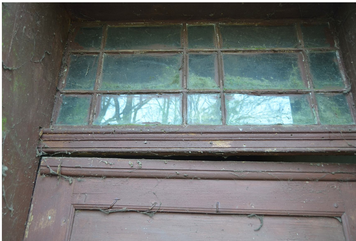
Il. 87 Dusocin – Budynek mieszkalny w zabytkowej zagrodzie wiejskiej – stolarka drzewiowa - drzwi wejściowe boczne (D/2) – widok na nadświetle i fragment śłemia oraz skrzydła fot. Ewa Bożejwicz 2018 r.
