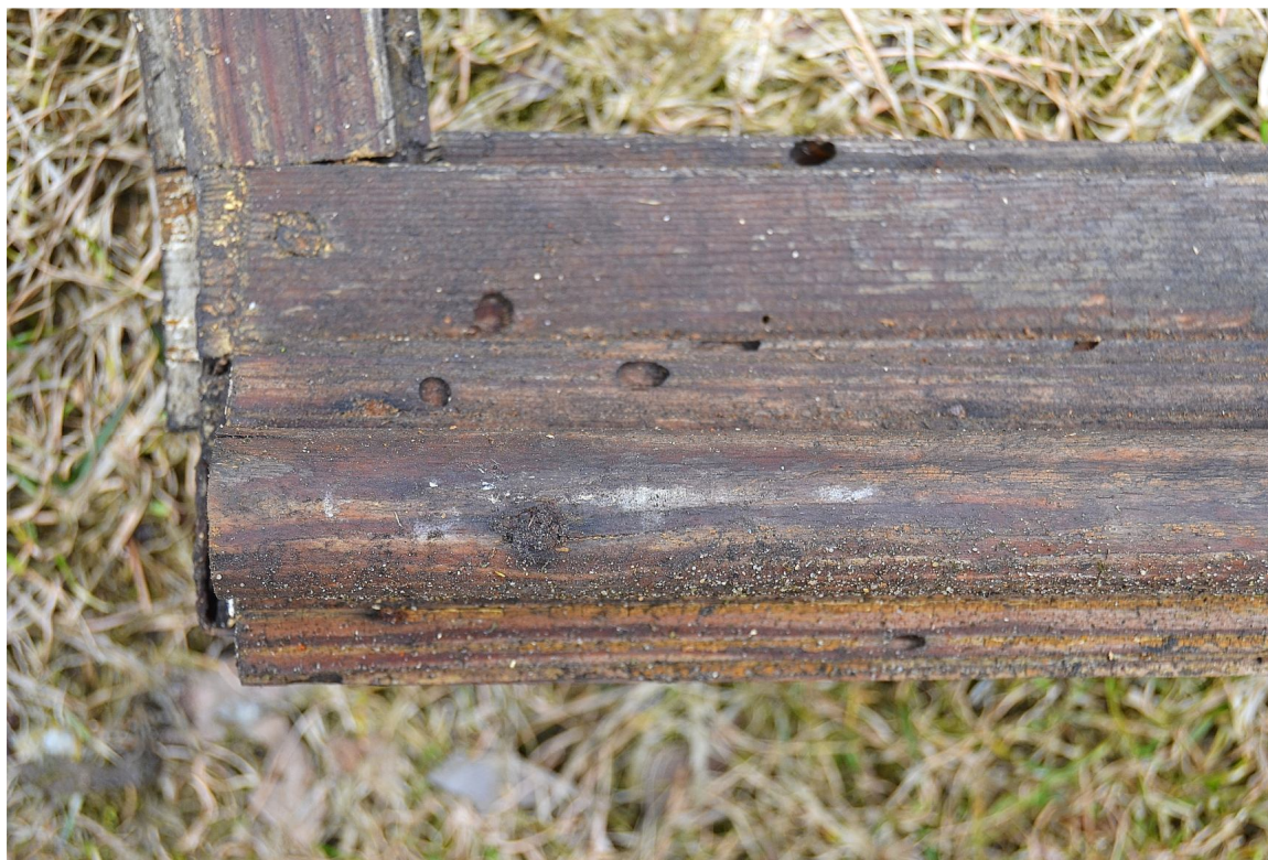
Il. 13 Dusocin – Budynek mieszkalny w zabytkowej zagrodzie wiejskiej – stolarka okienna - parter – widok na fragment skrzydła okiennego z listwą przymykową pierwotnej stolarki okiennej fot. Ewa Bożejewicz 2018 r.
