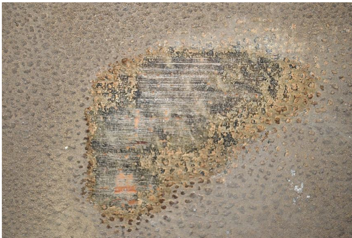
Il. 83 Dusocin – Budynek mieszkalny w zabytkowej zagrodzie wiejskiej – stolarka drzewiowa - drzwi wejściowe główne – odkrywka pierwotnej warstwy malarskiej drzwi w rewersie fot. Ewa Bożejewicz 2018 r.
