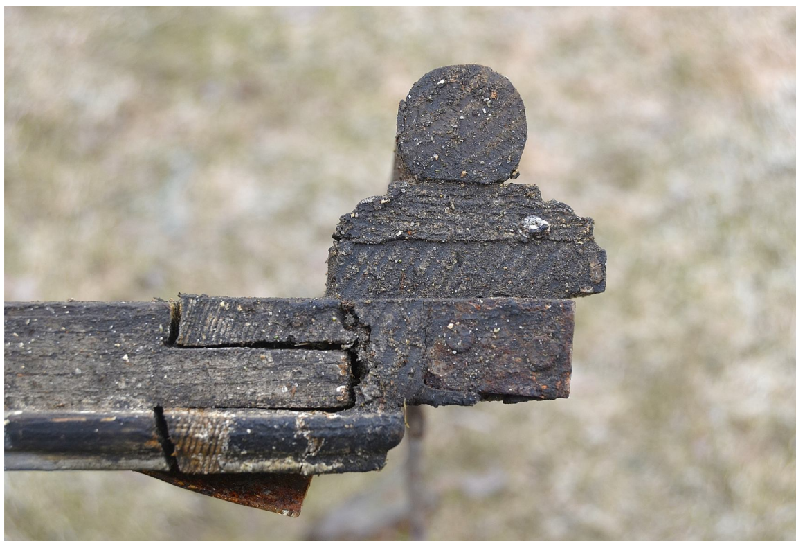
Il. 14 Dusocin – Budynek mieszkalny w zabytkowej zagrodzie wiejskiej – stolarka okienna - parter – widok na połączenie ramiaków oraz przekrój listwy przymykowej pierwotnej stolarki okiennej fot. Ewa Bożejewicz 2018 r.
