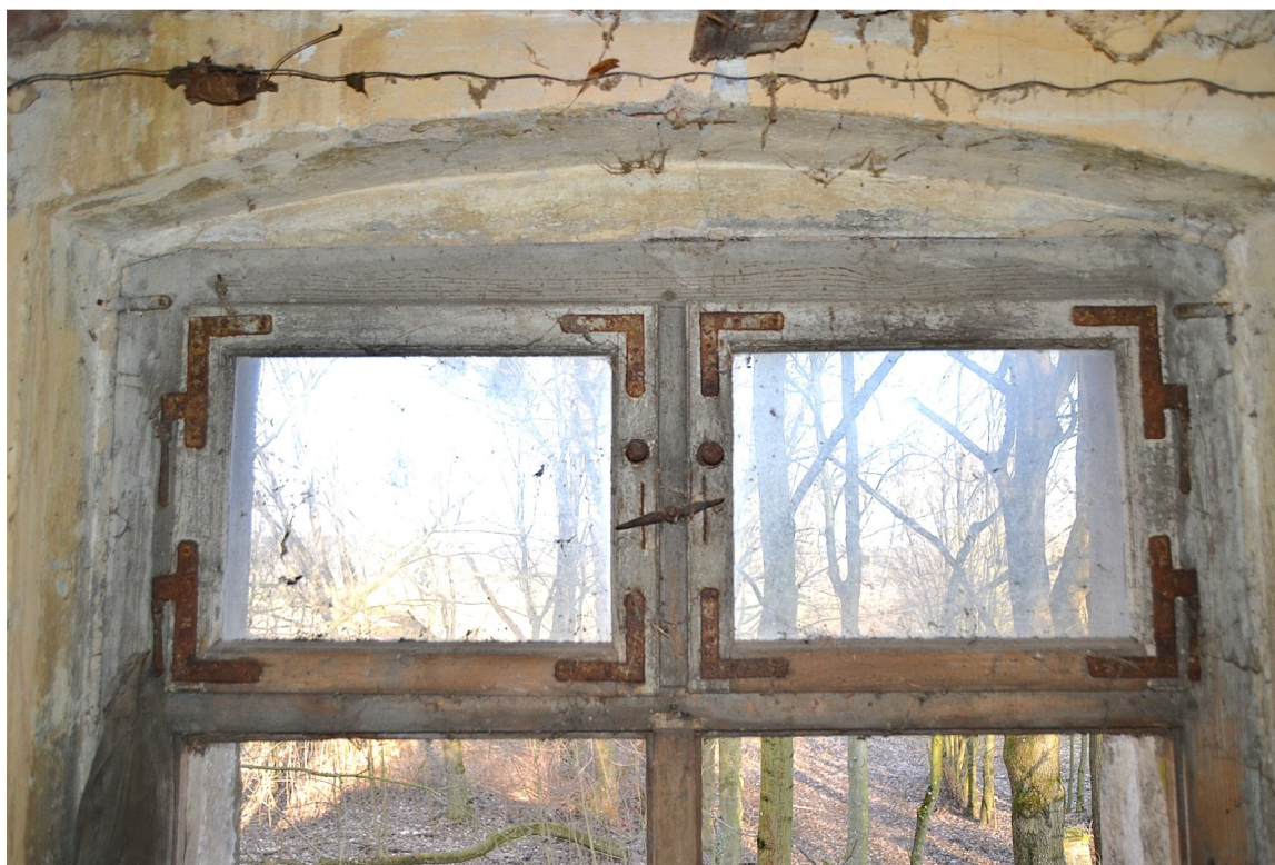
Il. 32 Dusocin – Budynek mieszkalny w zabytkowej zagrodzie wiejskiej – stolarka okienna - poddasze (szczyt) – widok na nadświetle pierwotnej stolarki okiennej
