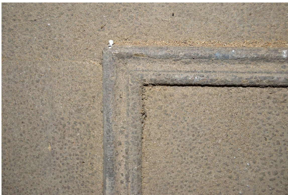
Il. 74 Dusocin – Budynek mieszkalny w zabytkowej zagrodzie wiejskiej – stolarka drzwiowa - drzwi wejściowe główne (D/1) – widok na profilowane listwy imitujące płycinę
