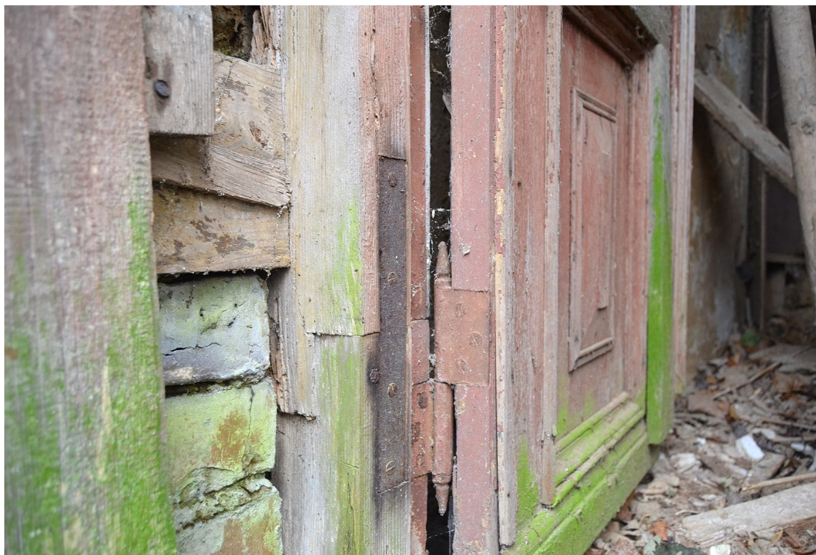
Il. 101 Dusocin – Budynek mieszkalny w zabytkowej zagrodzie wiejskiej – stolarka drzwiowa - drzwi wejściowe tylne (D/3) – widok na fragment ościeżnicy oraz skrzydła drzwiowego
