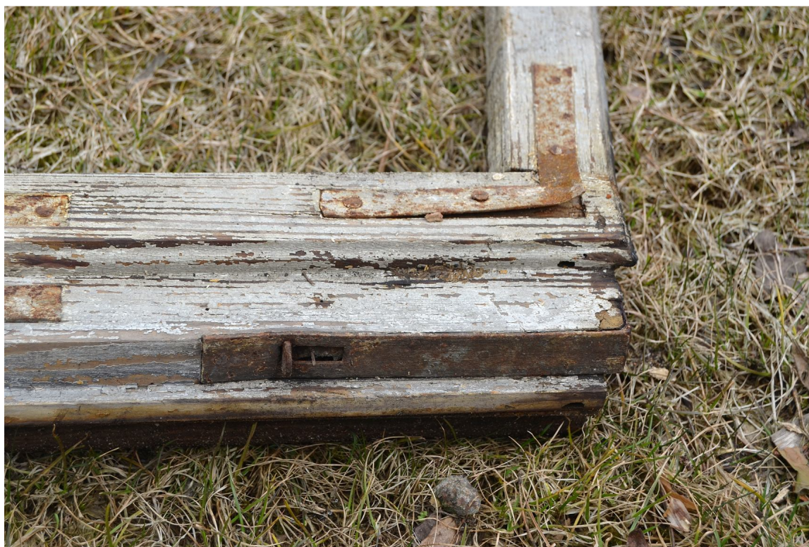
Il. 26 Dusocin – Budynek mieszkalny w zabytkowej zagrodzie wiejskiej – stolarka okienna - pierwotna stolarka okienna – widok na zasuwkę narożną wpuszczaną oraz narożnik okienny
