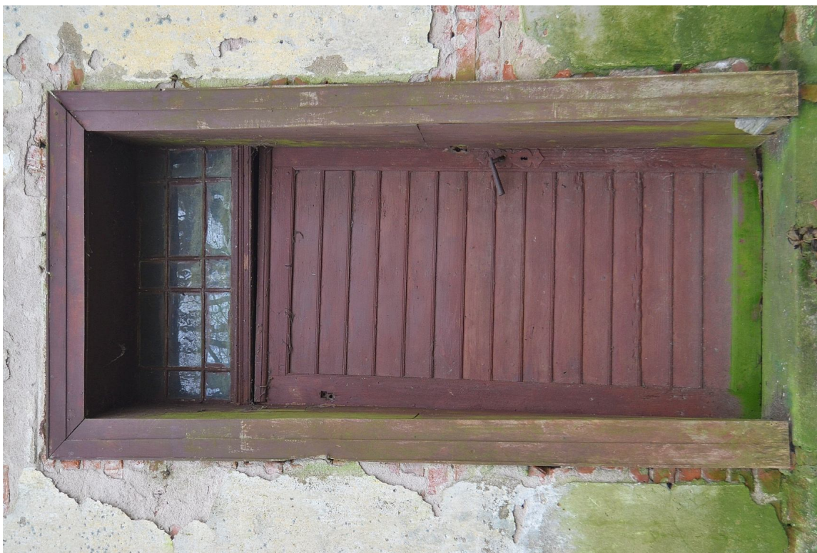
Il. 85 Dusocin – Budynek mieszkalny w zabytkowej zagrodzie wiejskiej – stolarka drzwiowa - drzwi wejściowe boczne (D/2) - awers
