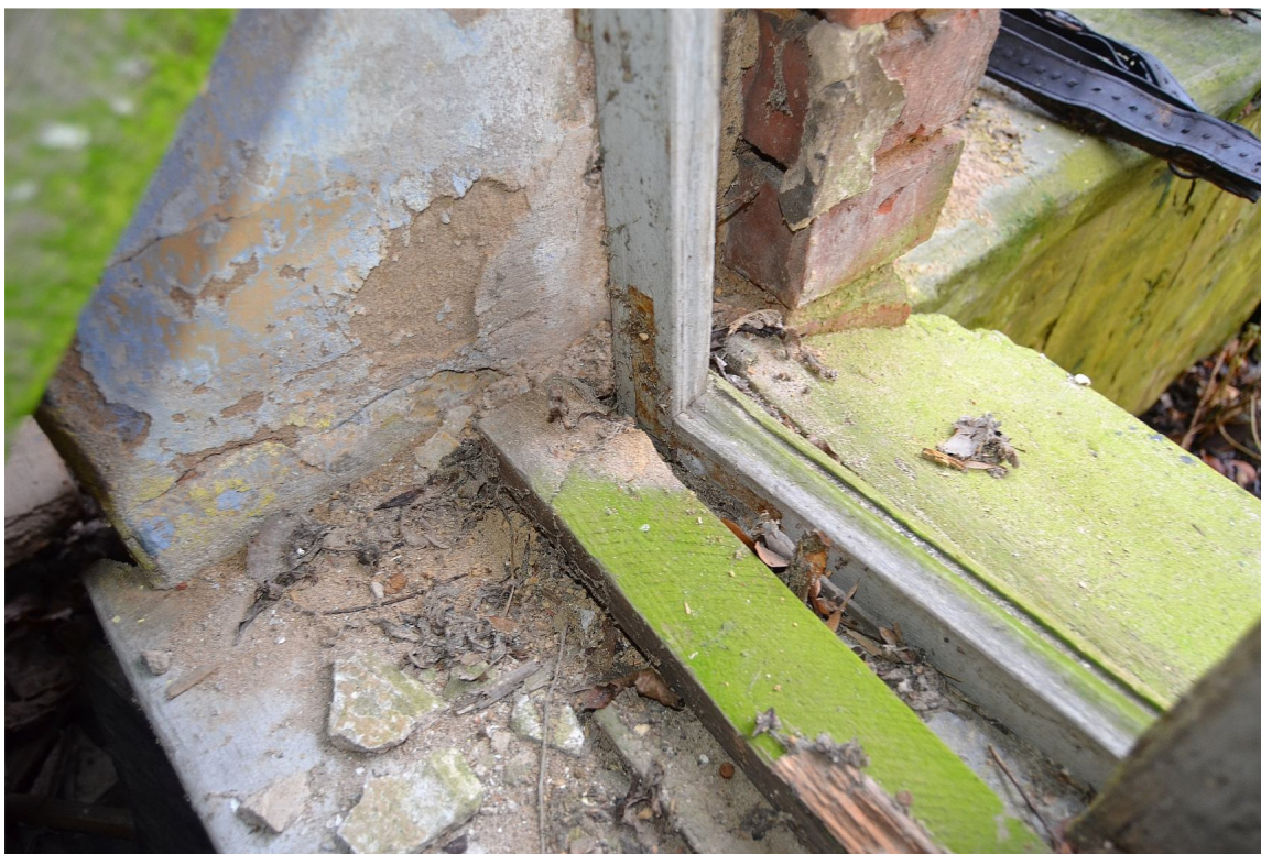
Il. 9 Dusocin – Budynek mieszkalny w zabytkowej zagrodzie wiejskiej – stolarka okienna - parter – widok na fragment pierwotnej stolarki okiennej oraz parapet zewnętrzny i wewnętrzny fot. Ewa Bożejewicz 2018 r.
