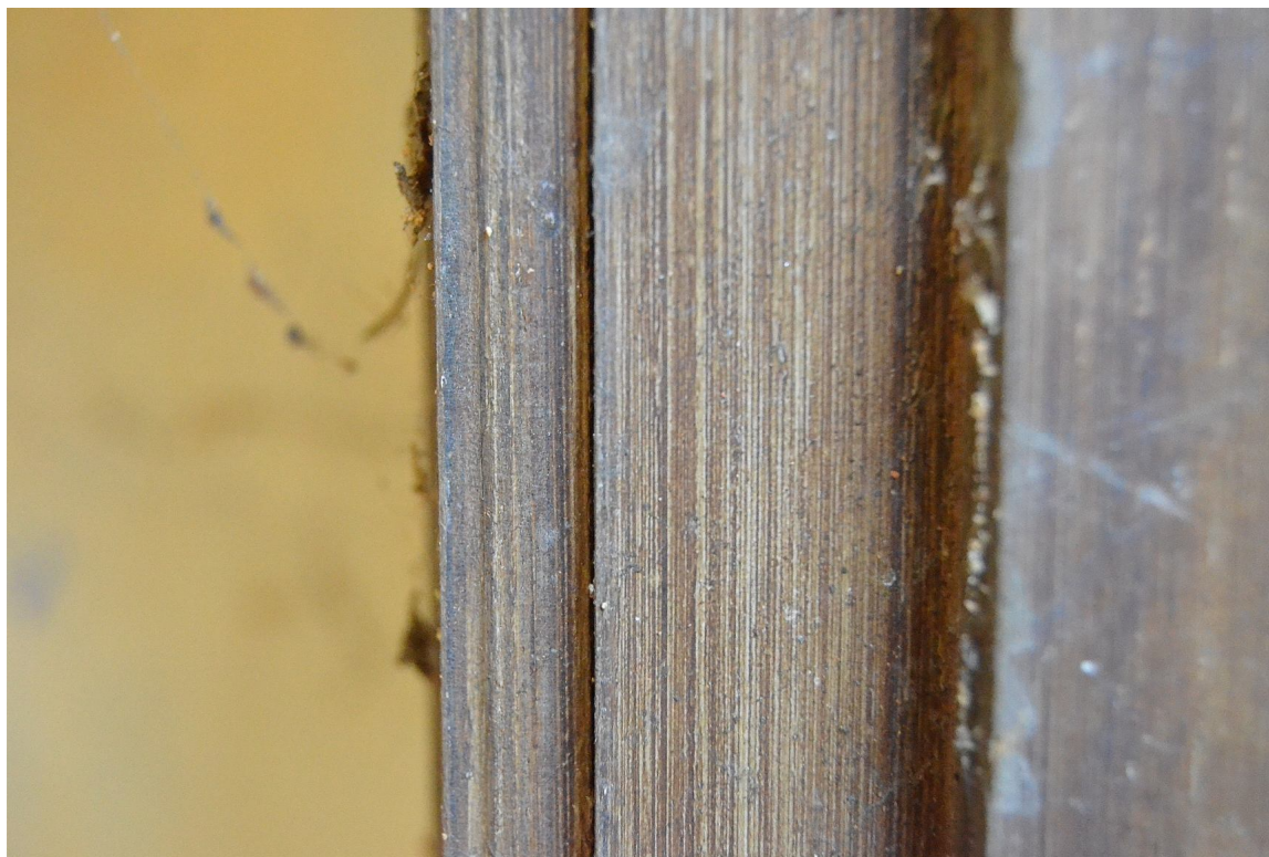
Il. 138 Dusocin – Budynek mieszkalny w zabytkowej zagrodzie wiejskiej – stolarka drzwiowa - drzwi wewnętrzne TYP III – widok na mazerowany stojak ościeżnicy drzwi na poddaszu (D/2)
