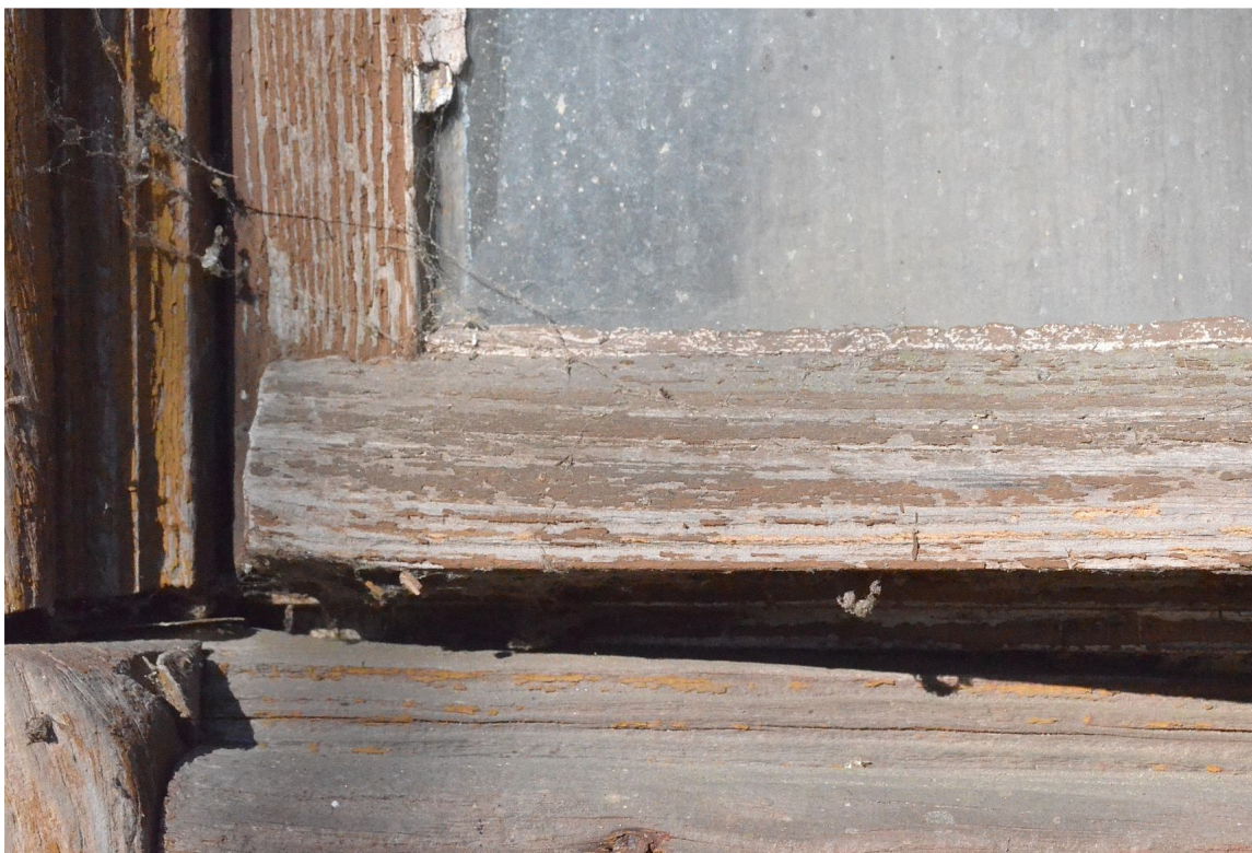
Il. 15 Dusocin – Budynek mieszkalny w zabytkowej zagrodzie wiejskiej – stolarka okienna - parter – widok na okapnik skrzydła pierwotnej stolarki okiennej
