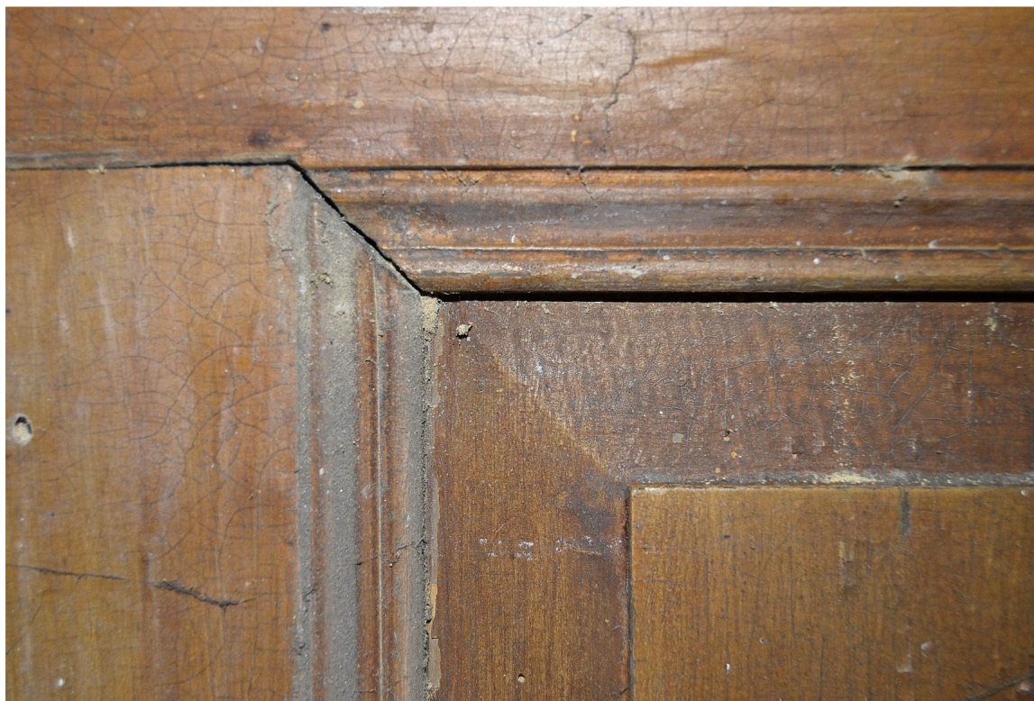
Il. 115 Dusocin – Budynek mieszkalny w zabytkowej zagrodzie wiejskiej – stolarka drzwiowa - drzwi wewnętrzne TYP (D/4) – widok na rozprofilowanie ramiaka oraz fragment płyciny z lustrem fot. Ewa Bożejewicz 2018 r.
