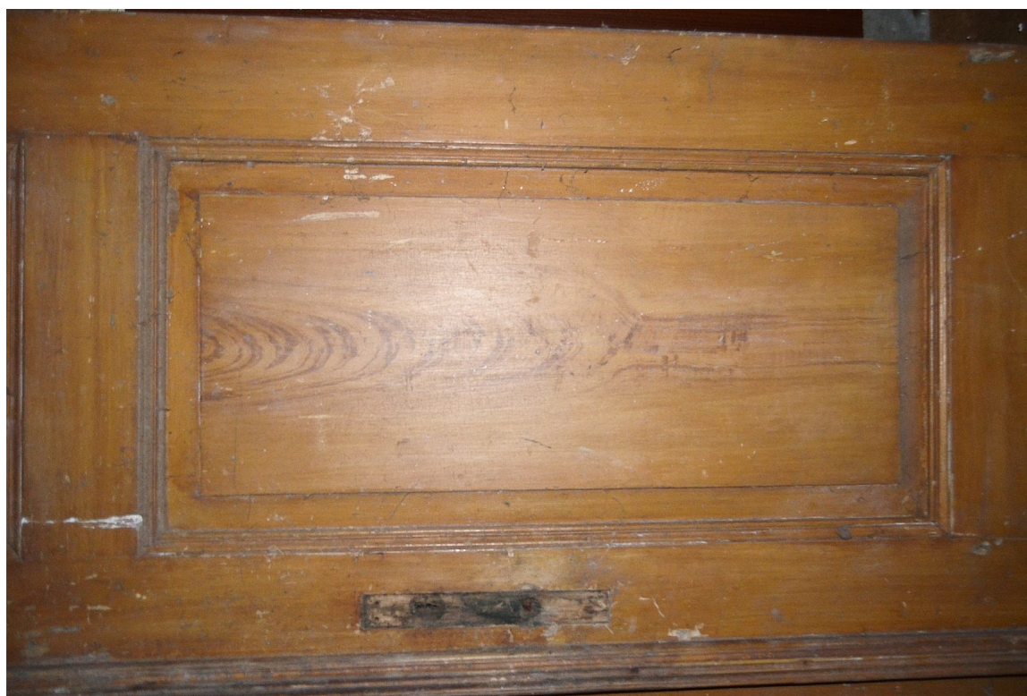
Il. 114 Dusocin – Budynek mieszkalny w zabytkowej zagrodzie wiejskiej – stolarka drzwiowa - drzwi wewnętrzne TYP (D/4) – widok na fragment skrzydła drzwiowego i mazerunki fot. Ewa Bożejewicz 2018 r.
