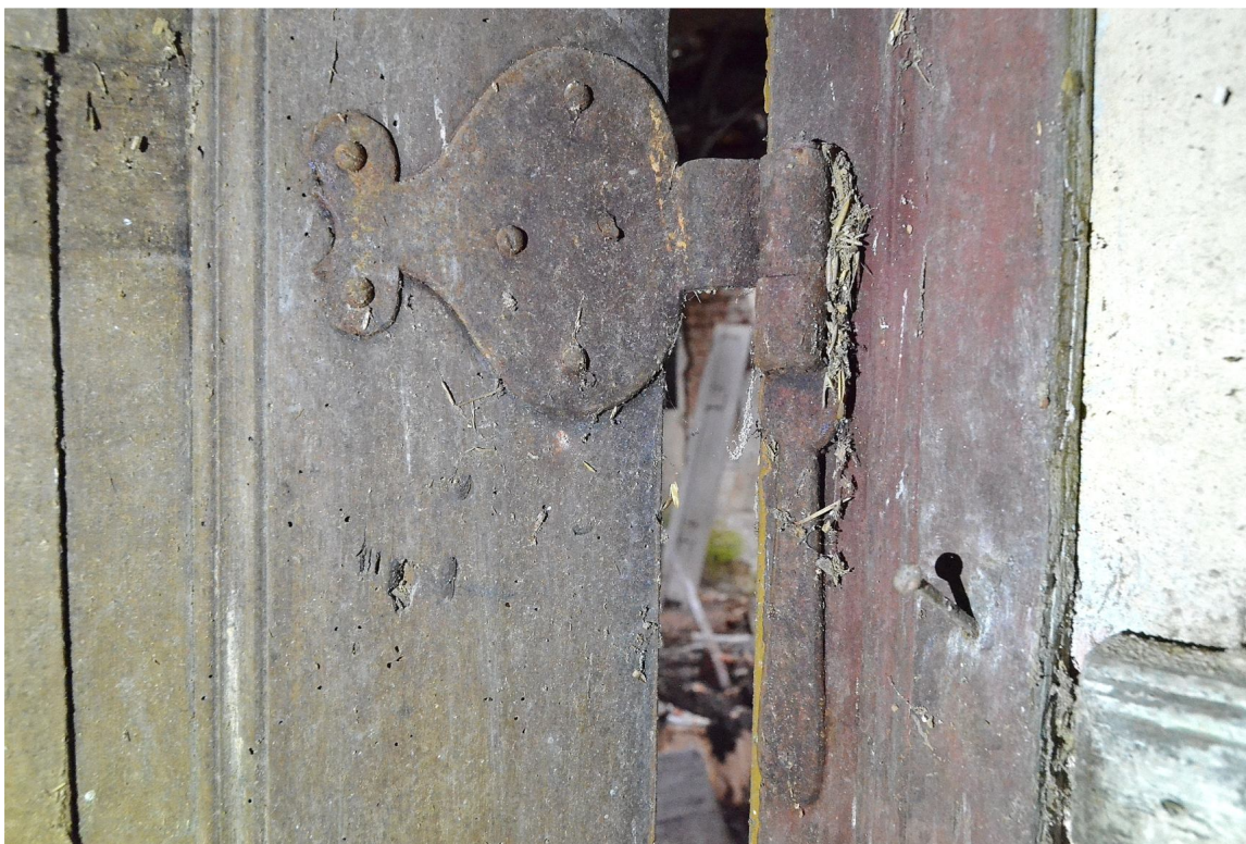
Il. 127 Dusocin – Budynek mieszkalny w zabytkowej zagrodzie wiejskiej – stolarka drzwiowa - drzwi wewnętrzne TYP (D/6) – widok na pierwotny zawias hakowy tarczowy
