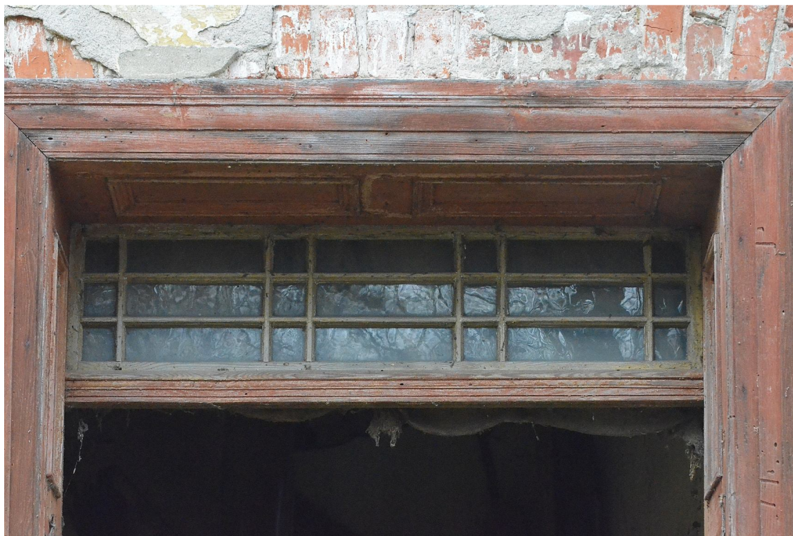
Il. 61 Dusocin – Budynek mieszkalny w zabytkowej zagrodzie wiejskiej – stolarka drzewiowa - drzwi wejściowe główne (D/1) – widok na nadświetle i opaski drzwiowe
