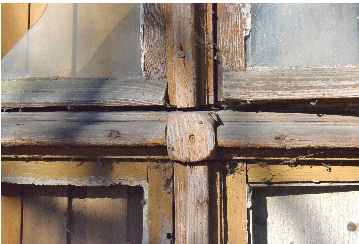
Il. 10 Dusocin – Budynek mieszkalny w zabytkowej zagrodzie wiejskiej – stolarka okienna - parter – widok na fragment krzyża okiennego z kostką pierwotnej stolarki okiennej fot. Ewa Bożejewicz 2018 r.
