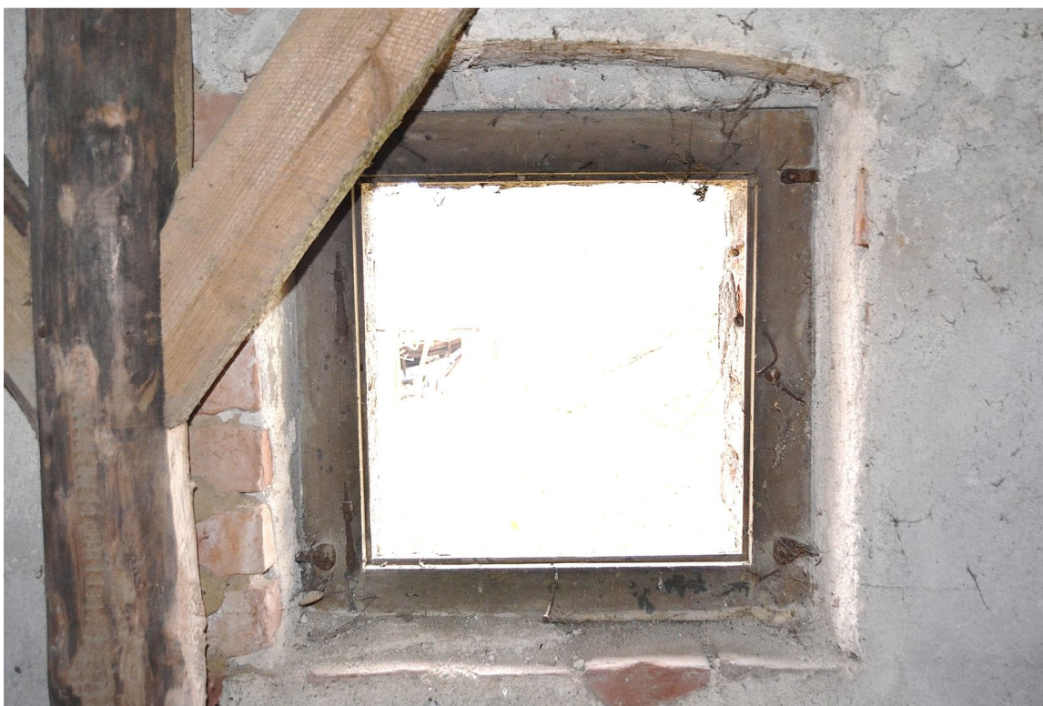
Il. 36 Dusocin – Budynek mieszkalny w zabytkowej zagrodzie wiejskiej – stolarka okienna - poddasze (ścianka kolankowa) – widok na otwór okienny z zachowanym pierwotnym krosnem
