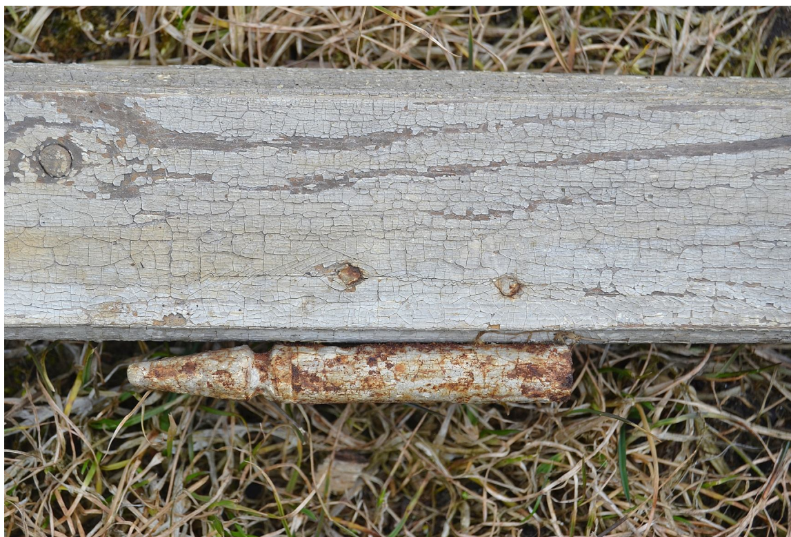
Il. 20 Dusocin – Budynek mieszkalny w zabytkowej zagrodzie wiejskiej – stolarka okienna - widok na pierwotny zawias czopowy wpuszczany o fazowanej główce
