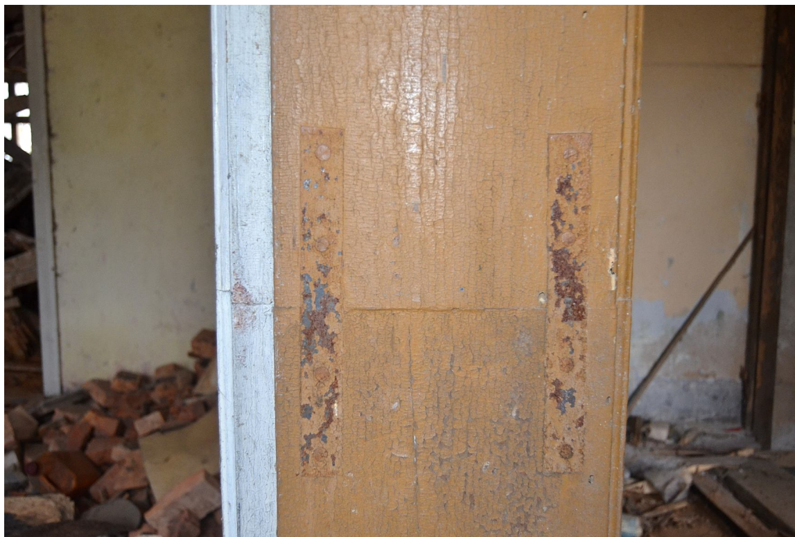
Il. 124 Dusocin – Budynek mieszkalny w zabytkowej zagrodzie wiejskiej – stolarka drzwiowa - drzwi wewnętrzne TYP II – widok na połączenie dwóch odcinków ościeżyny płaskownikami (D/4)
