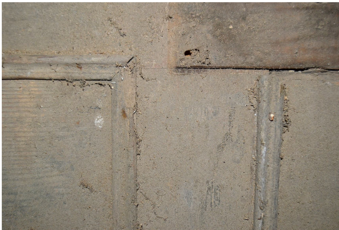
Il. 73 Dusocin – Budynek mieszkalny w zabytkowej zagrodzie wiejskiej – stolarka drzwiowa - drzwi wejściowe główne (D/1) – widok na fragment skrzydła - rewers
