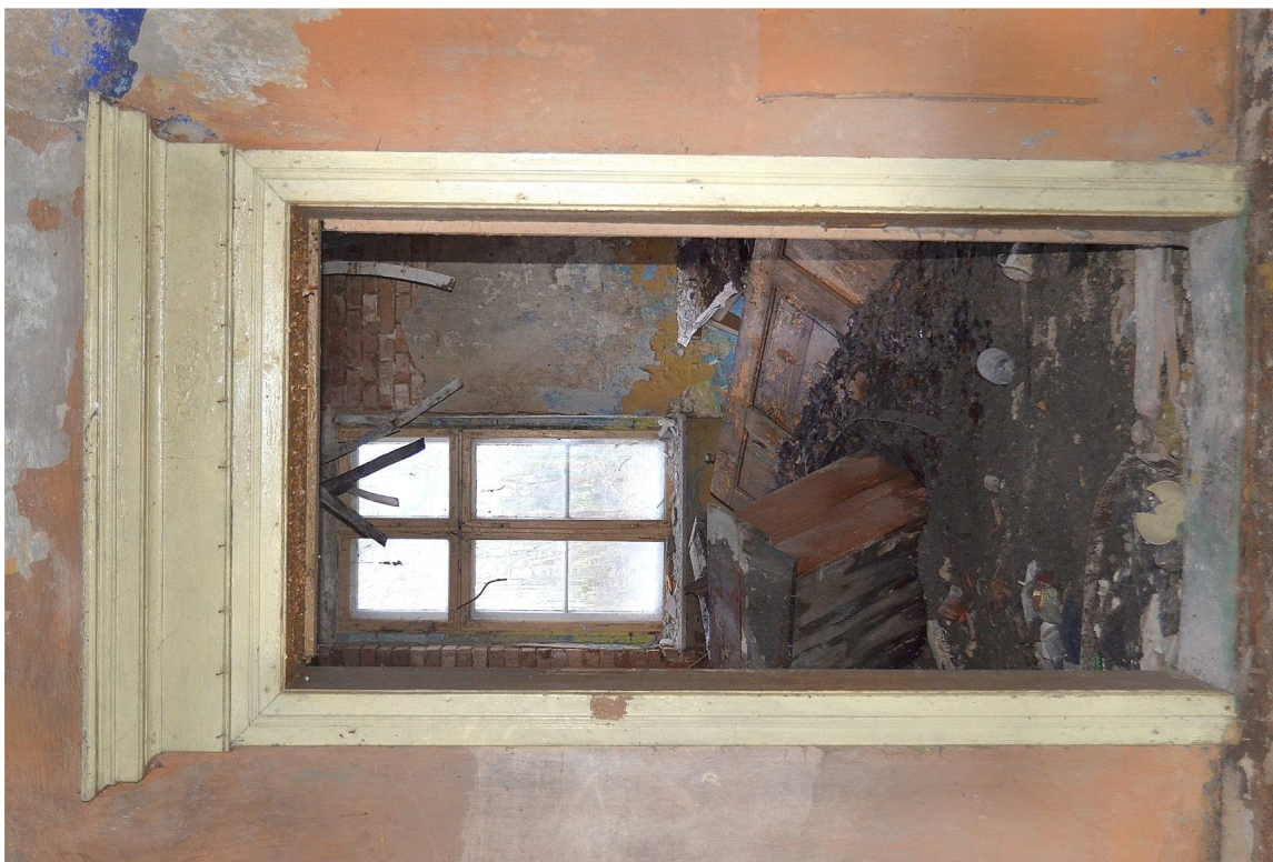
II. 119 Dusocin – Budynek mieszkalny w zabytkowej zagrodzie wiejskiej – stolarka drzwiowa - drzwi wewnętrzne TYP (D/5) – widok na ościeżynę z opaskami oraz przyczółkiem (D/13) fot. Ewa Bożejewicz 2018 r.
