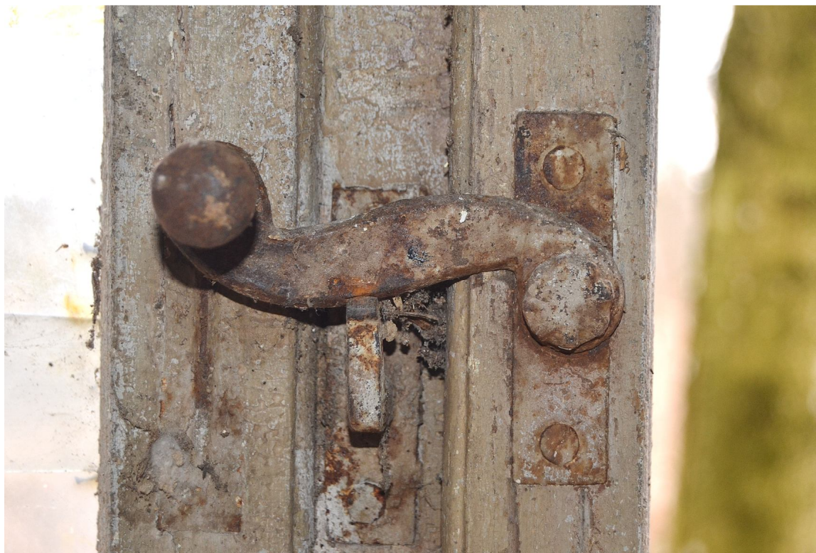
Il. 23 Dusocin – Budynek mieszkalny w zabytkowej zagrodzie wiejskiej – stolarka okienna - widok na fragment pierwotnej stolarki okiennej z zakrętką dźwigniową z hakiem i podkładką
