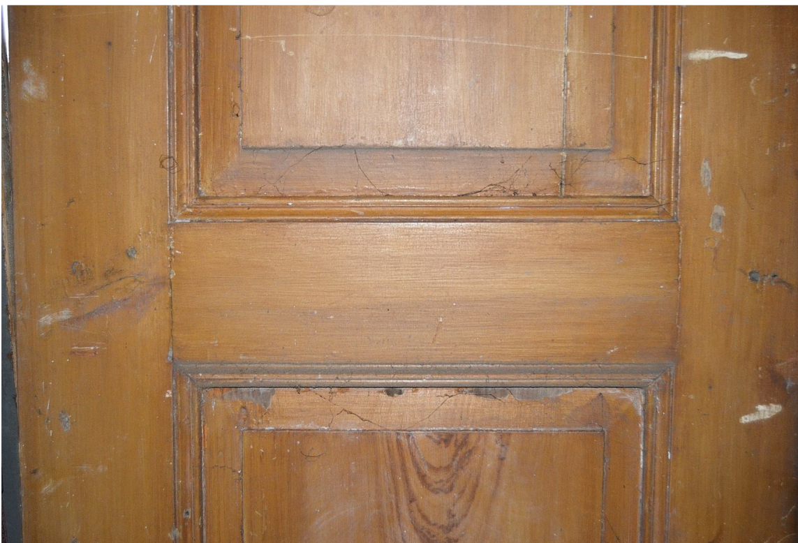
Il. 113 Dusocin – Budynek mieszkalny w zabytkowej zagrodzie wiejskiej – stolarka drzwiowa - drzwi wewnętrzne TYP (D/4) – widok na fragment skrzydła drzwiowego i mazerunki fot. Ewa Bożejewicz 2018 r.
