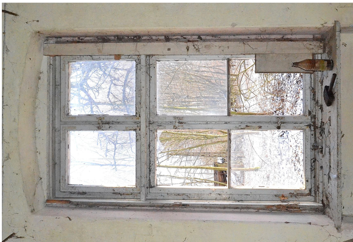
Il. 30 Dusocin – Budynek mieszkalny w zabytkowej zagrodzie wiejskiej – stolarka okienna - parter – widok na wtórną stolarkę okienną skrzynkową jednokrosnową - rewers
