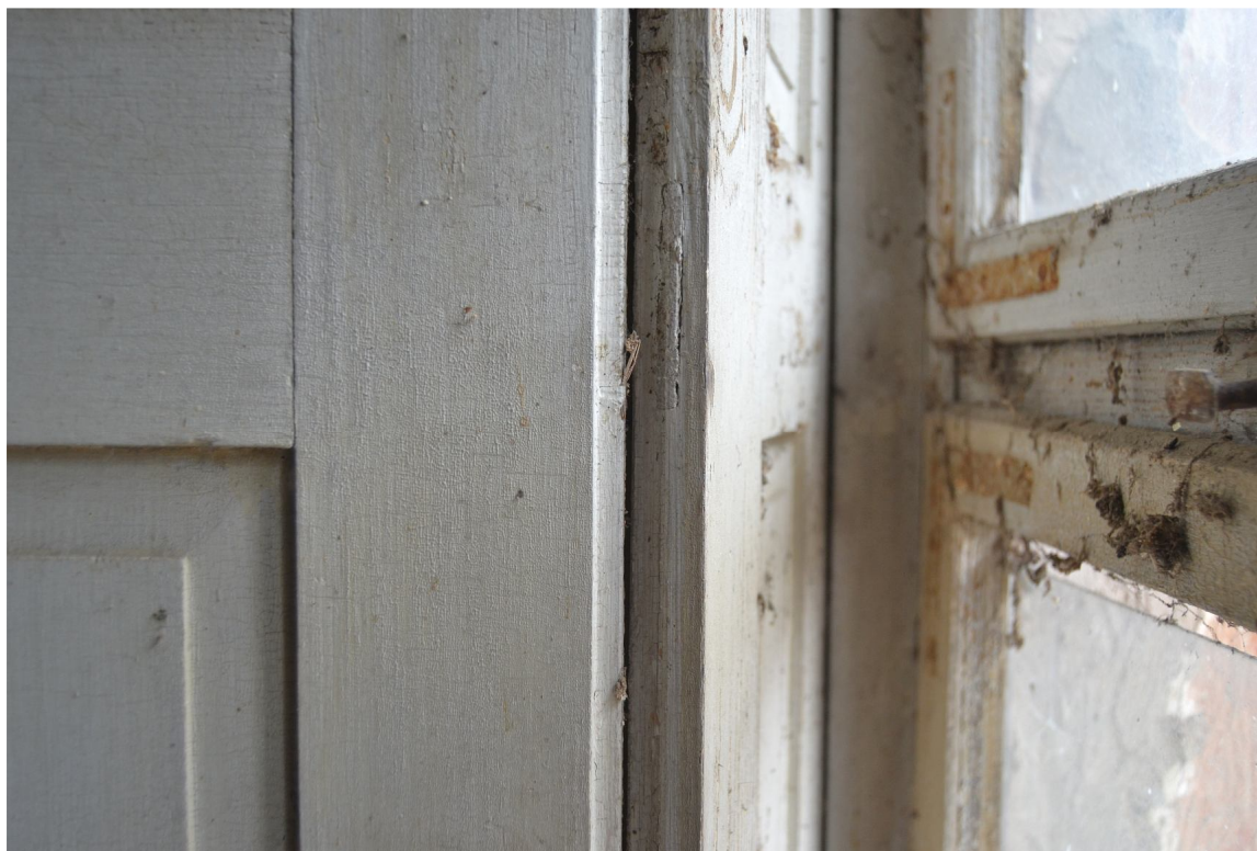
Il. 49 Dusocin – Budynek mieszkalny w zabytkowej zagrodzie wiejskiej – stolarka okienna - okiennice – widok na połączenie przylgowe dwóch części łamanego skrzydła okiennicy
