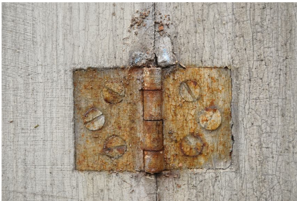
Il. 50 Dusocin – Budynek mieszkalny w zabytkowej zagrodzie wiejskiej – stolarka okienna - okiennice – widok na zawias czopowy splatany
