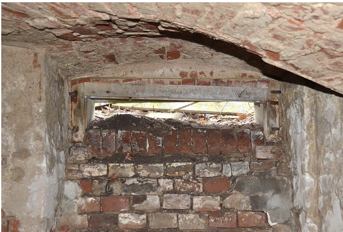
Il. 1 Dusocin – Budynek mieszkalny w zabytkowej zagrodzie wiejskiej – stolarka okienna - piwnica – widok na krosno pierwotnej stolarki okiennej o skrzydle półstałym
