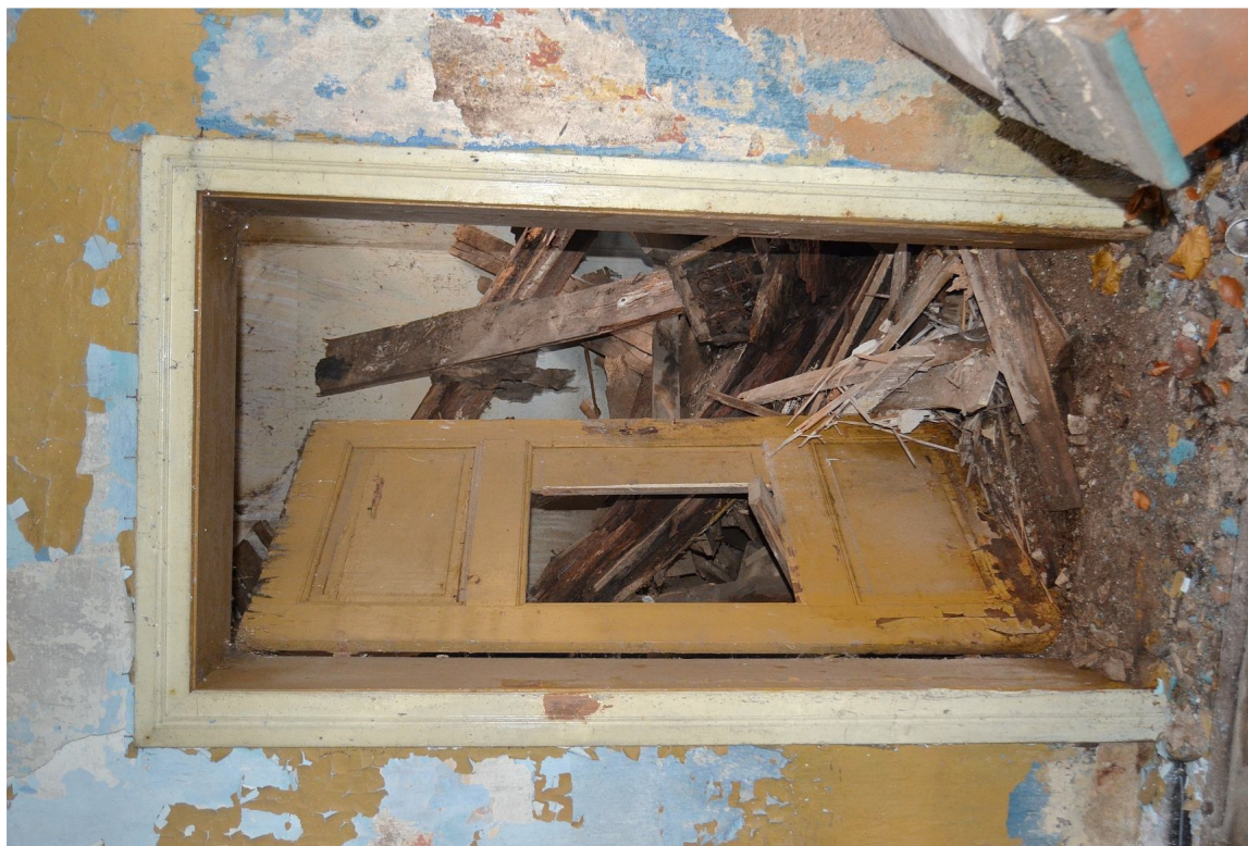
Il. 125 Dusocin – Budynek mieszkalny w zabytkowej zagrodzie wiejskiej – stolarka drzwiowa - drzwi wewnętrzne TYP (D/6) – drzwi pomiędzy kredensem a kuchnią
