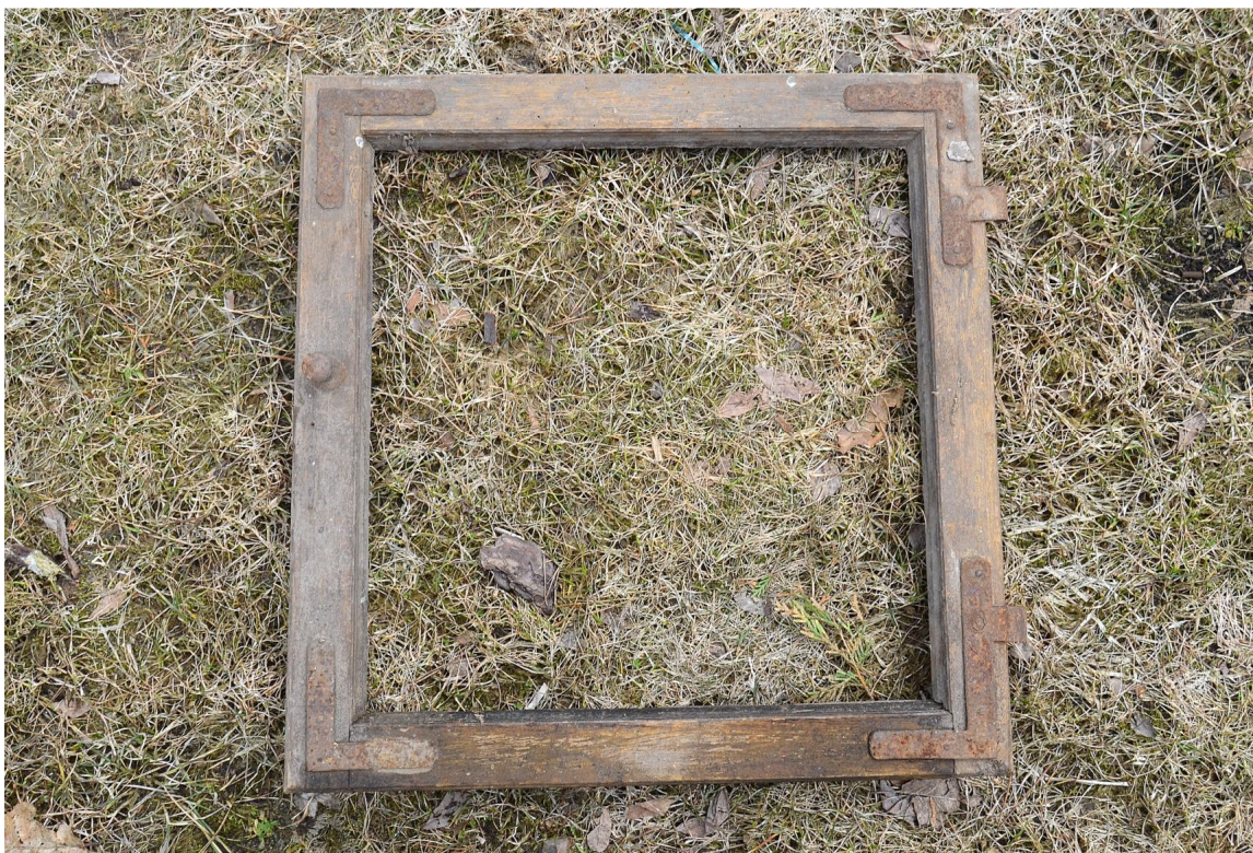
Il. 35 Dusocin – Budynek mieszkalny w zabytkowej zagrodzie wiejskiej – stolarka okienna - poddasze (ścianka kolankowa) – widok na pierwotne skrzydło okienne
