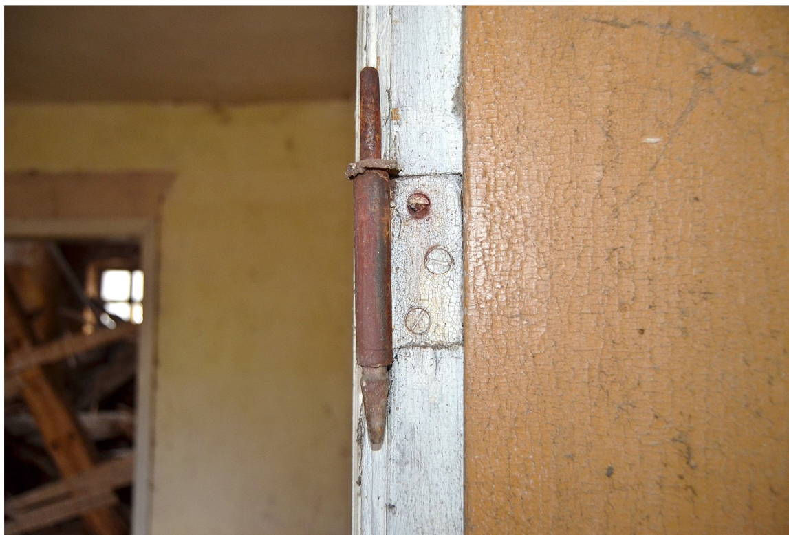
Il. 123 Dusocin – Budynek mieszkalny w zabytkowej zagrodzie wiejskiej – stolarka drzwiowa - drzwi wewnętrzne TYP (D/5) – widok na zawias czopowy nakładany
