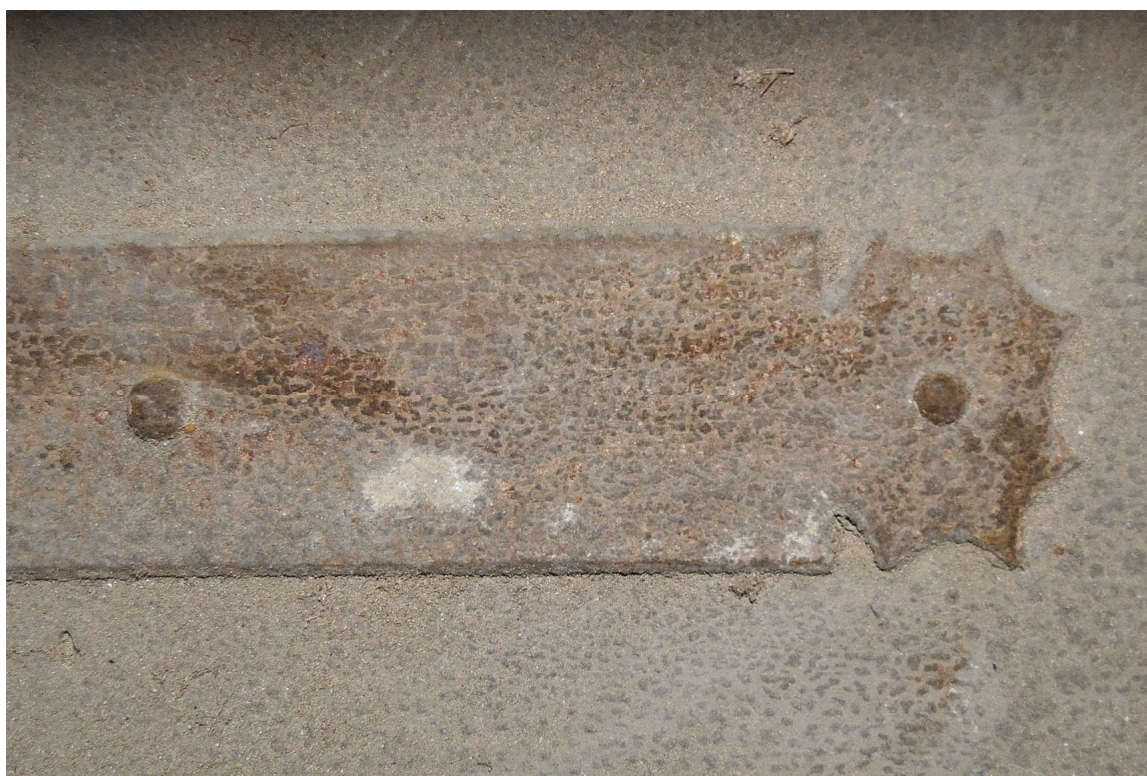
Il. 78 Dusocin – Budynek mieszkalny w zabytkowej zagrodzie wiejskiej – stolarka drzwiowa - drzwi wejściowe główne (D/1) – widok na fragment zawiasa hakowego kąowego
