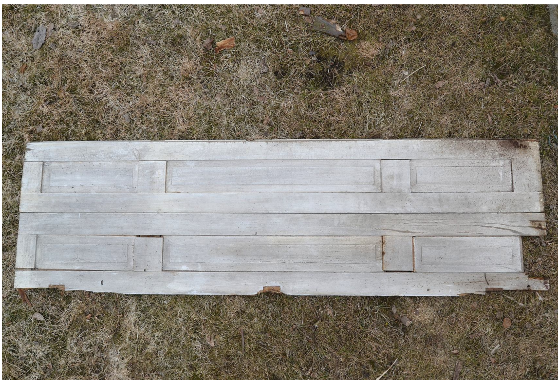
Il. 44 Dusocin – Budynek mieszkalny w zabytkowej zagrodzie wiejskiej – stolarka okienna - okiennice – widok na skrzydło okiennicy - rewers
