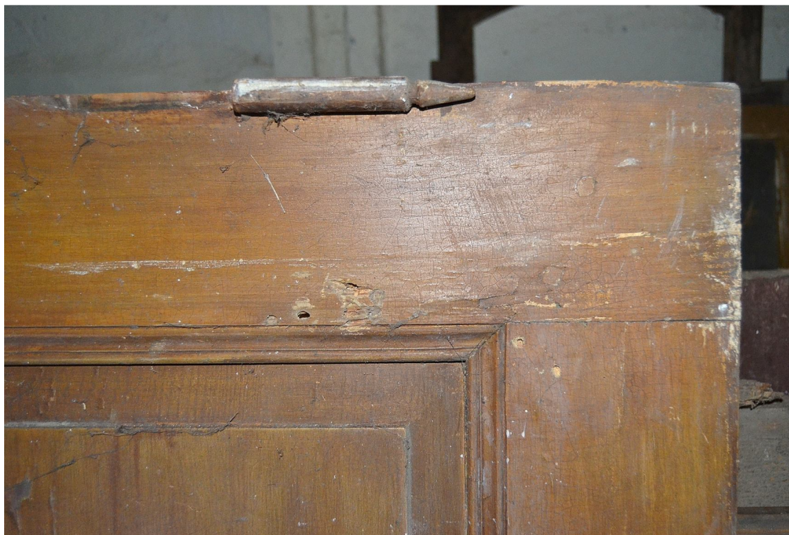
Il. 111 Dusocin – Budynek mieszkalny w zabytkowej zagrodzie wiejskiej – stolarka drzwiowa - drzwi wewnętrzne TYP (D/4) – widok na fragment skrzydła drzwiowego z zawiasem czopowym fot. Ewa Bożejewicz 2018 r.
