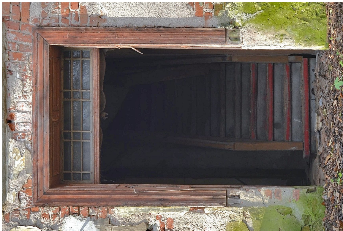
Il. 59 Dusocin – Budynek mieszkalny w zabytkowej zagrodzie wiejskiej – stolarka drzwiowa - drzwi wejściowe główne (D/1) – awers
