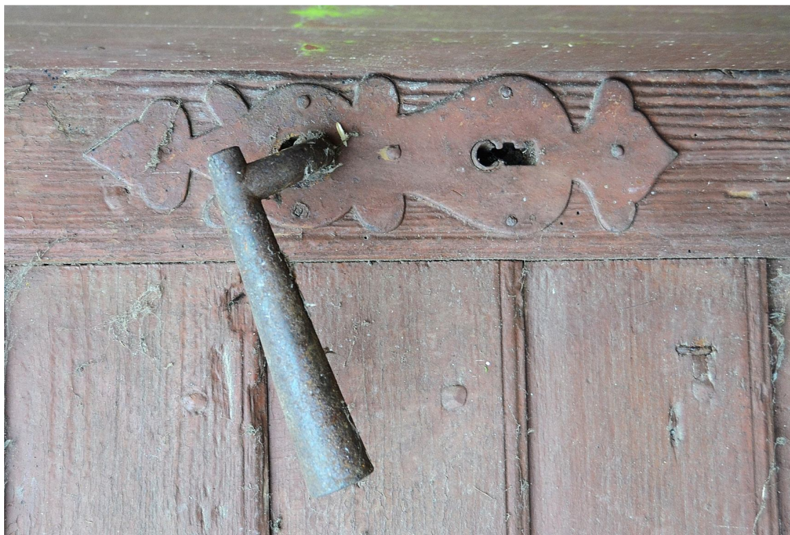
Il. 93 Dusocin – Budynek mieszkalny w zabytkowej zagrodzie wiejskiej – stolarka drzwiowa - drzwi wejściowe boczne (D/2) – widok na pierwotną klamkę drzwiową z szyldem
