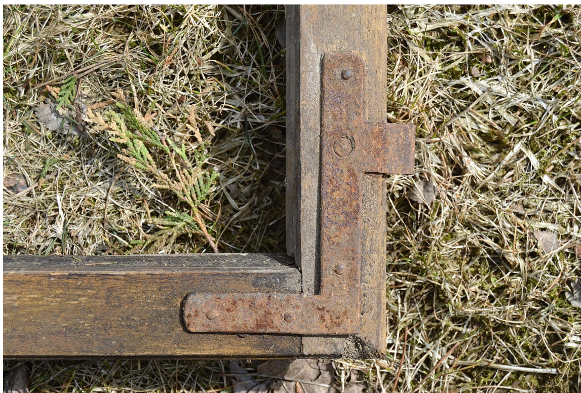
Il. 38 Dusocin – Budynek mieszkalny w zabytkowej zagrodzie wiejskiej – stolarka okienna - poddasze (ścianka kolankowa) – widok na fragment pierwotnego skrzydła z zawiasem hakowym kątowym fot. Ewa Bożejewicz 2018 r.
