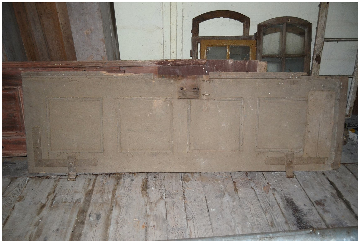
Il. 72 Dusocin – Budynek mieszkalny w zabytkowej zagrodzie wiejskiej – stolarka drzwiowa - drzwi wejściowe główne (D/1) – widok na jedno ze skrzydeł drzwiowych - rewers fot. Ewa Bożejewicz 2018 r.
