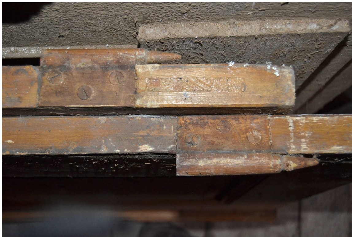
Il. 118 Dusocin – Budynek mieszkalny w zabytkowej zagrodzie wiejskiej – stolarka drzwiowa - drzwi wewnętrzne TYP (D/4) – widok na połączenie czopowe ramiaków oraz zawias czopowy nakładany fot. Ewa Bożejewicz 2018 r.
