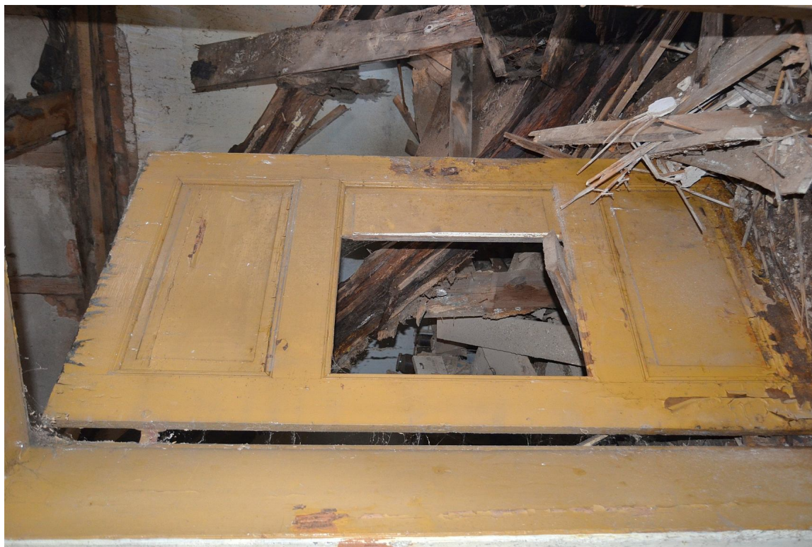
Il. 126 Dusocin – Budynek mieszkalny w zabytkowej zagrodzie wiejskiej – stolarka drzwiowa - drzwi wewnętrzne TYP (D/6) – widok na pierwotne skrzydło drzwiowe
