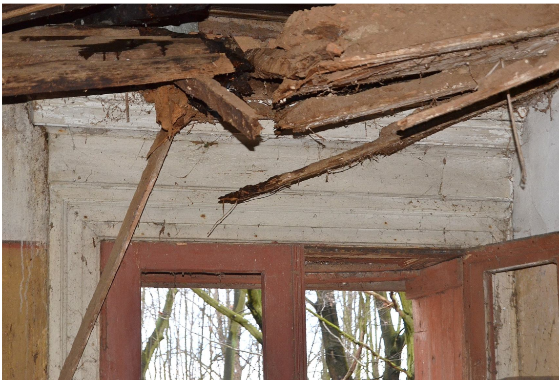
II. 105 Dusocin – Budynek mieszkalny w zabytkowej zagrodzie wiejskiej – stolarka drzwiowa - drzwi wejściowe tylne (D/3) – widok na fragment drzwi i przyczółek w rewersie
