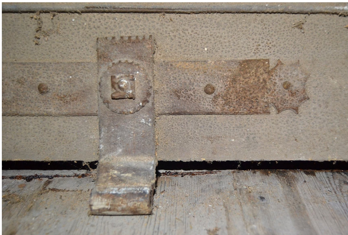
Il. 77 Dusocin – Budynek mieszkalny w zabytkowej zagrodzie wiejskiej – stolarka drzwiowa - drzwi wejściowe główne (D/1) – widok na fragment zawiasa hakowego kąowego
