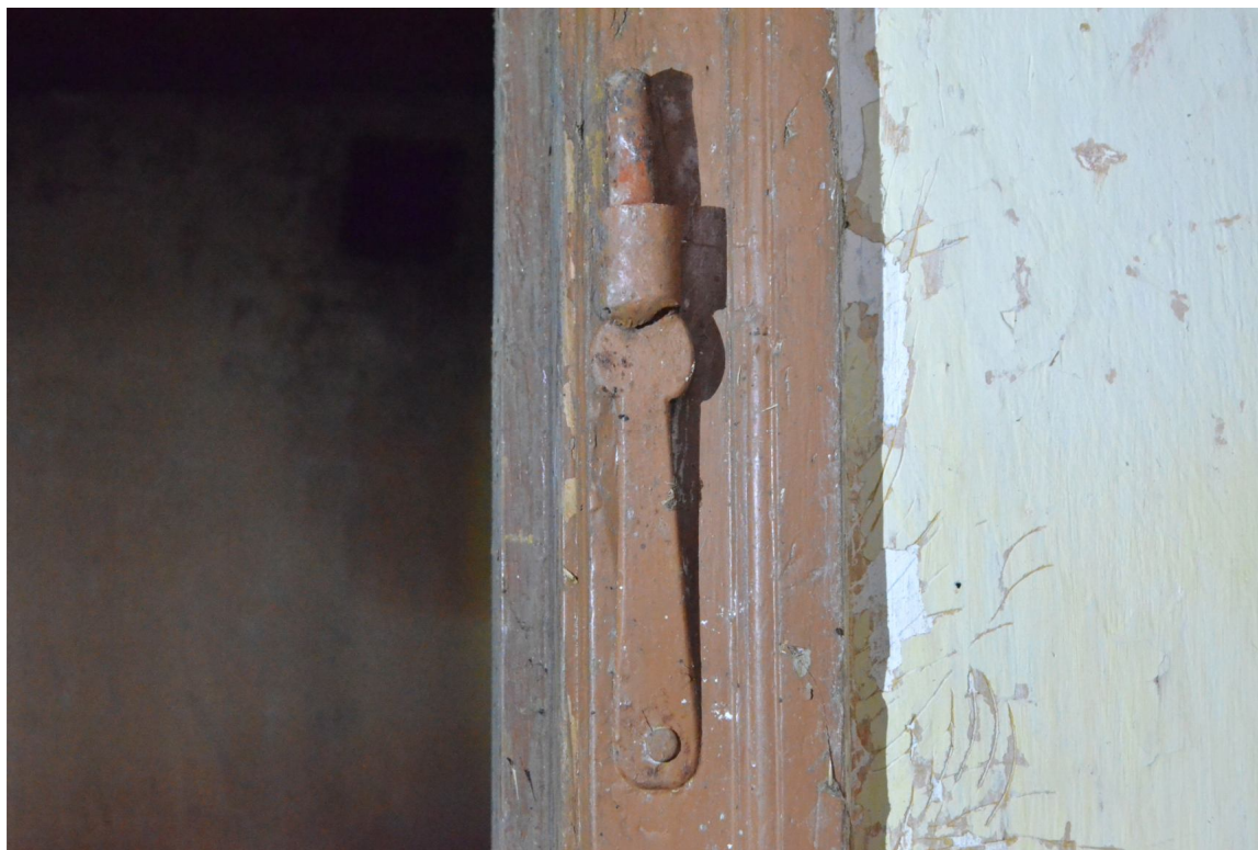
Il. 134 Dusocin – Budynek mieszkalny w zabytkowej zagrodzie wiejskiej – stolarka drzwiowa - drzwi wewnętrzne TYP III – widok na hak pierwotnego zawiasa hakowego drzwi (D/11) fot. Ewa Bożejewicz 2018 r.
