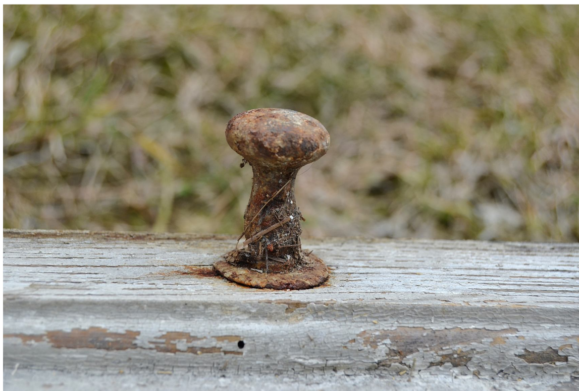
Il. 28 Dusocin – Budynek mieszkalny w zabytkowej zagrodzie wiejskiej – stolarka okienna - widok na pierwotną gałeczkę okienną
