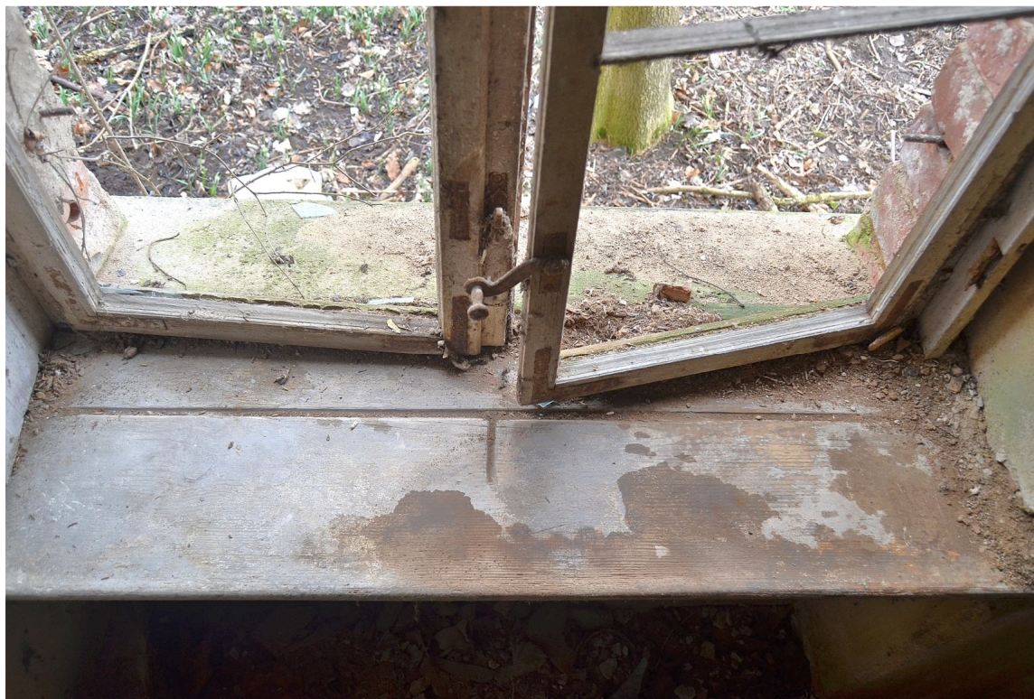
Il. 17 Dusocin – Budynek mieszkalny w zabytkowej zagrodzie wiejskiej – stolarka okienna - parter – widok na fragment stolarki oraz pierwotny parapet wewnętrzny z rynienką
