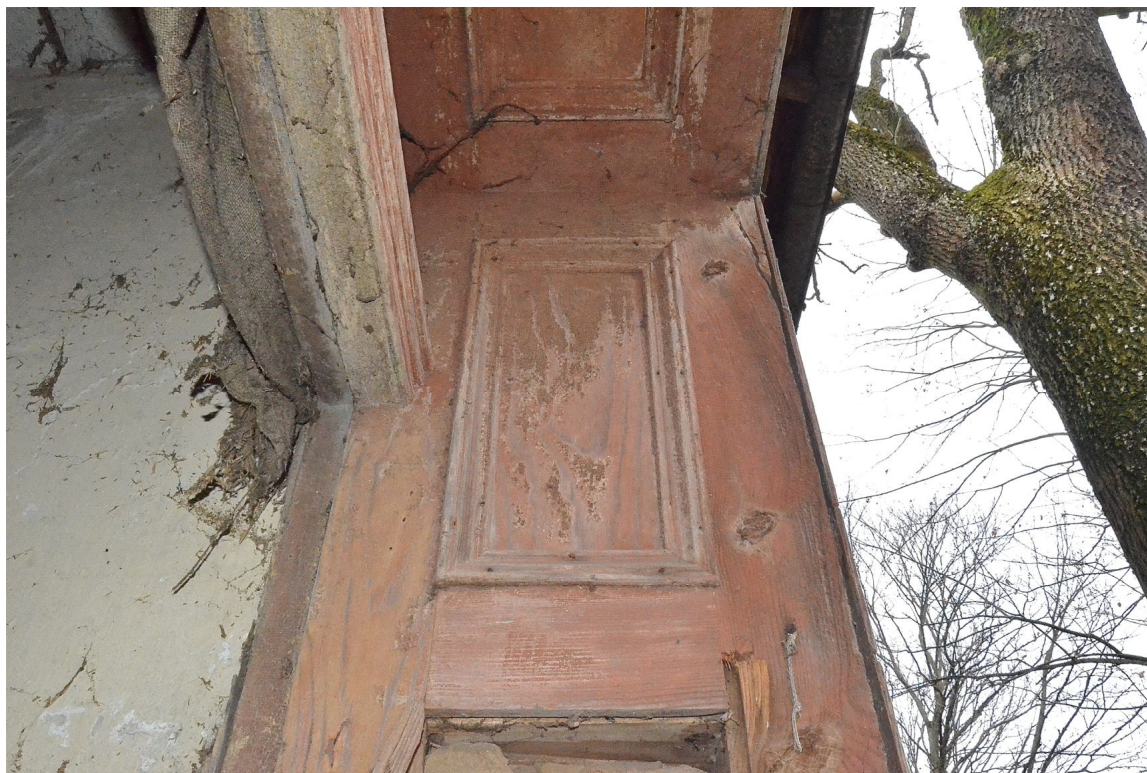
Il. 64 Dusocin – Budynek mieszkalny w zabytkowej zagrodzie wiejskiej – stolarka drzewiowa - drzwi wejściowe główne (D/1) – widok na ościeżinę ramowo-płycinową
