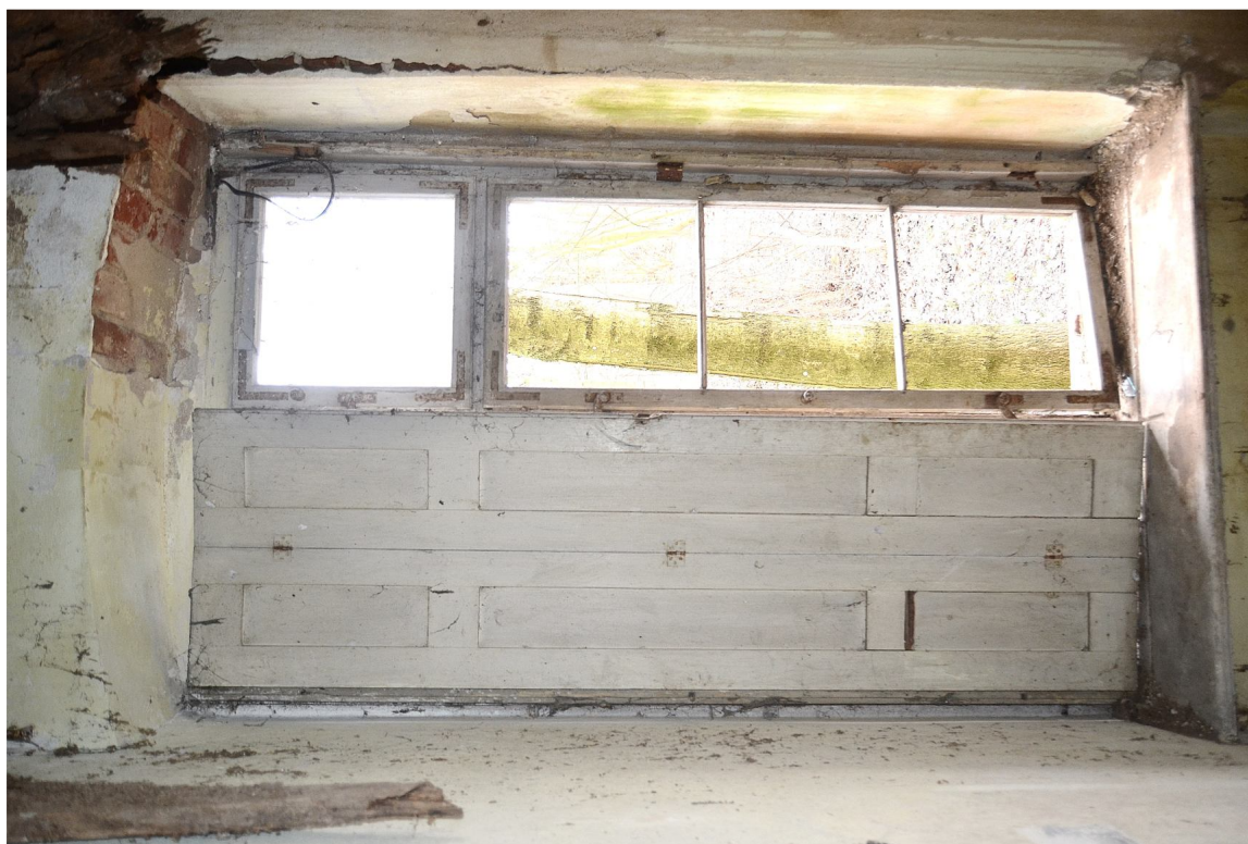
Il. 42 Dusocin – Budynek mieszkalny w zabytkowej zagrodzie wiejskiej – stolarka okienna - okiennice - widok na okiennicę zachowaną w oknie pomieszczeniu nr 3
