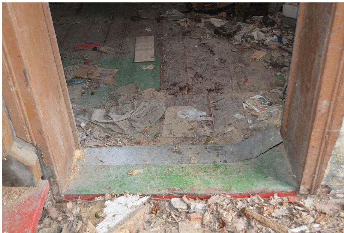
II. 121 Dusocin – Budynek mieszkalny w zabytkowej zagrodzie wiejskiej – stolarka drzwiowa - drzwi wewnętrzne TYP II – widok na próg i fragment ościeżyny z opaskami (D/14) fot. Ewa Bożejewicz 2018 r.
