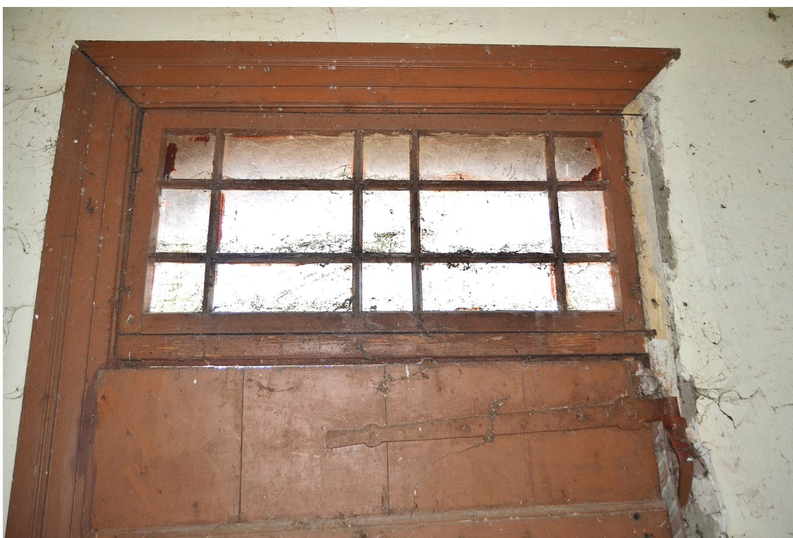
Il. 90 Dusocin – Budynek mieszkalny w zabytkowej zagrodzie wiejskiej – stolarka drzwiowa - drzwi wejściowe boczne (D/2) – widok na nadświetle i fragment skrzydła w rewersie
