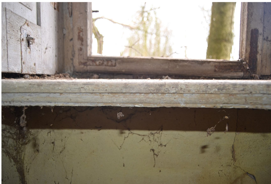
Il. 18 Dusocin – Budynek mieszkalny w zabytkowej zagrodzie wiejskiej – stolarka okienna - parter – widok na nosek pierwotnego parapetu wewnętrznego
