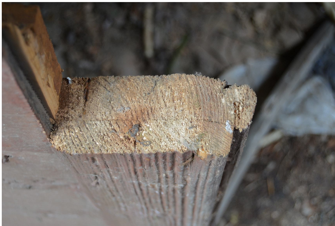
Il. 96 Dusocin – Budynek mieszkalny w zabytkowej zagrodzie wiejskiej – stolarka drzwiowa - drzwi wejściowe boczne (D/3) – widok na przekrój ramiaka pionowego oraz listwę opierzeniową
