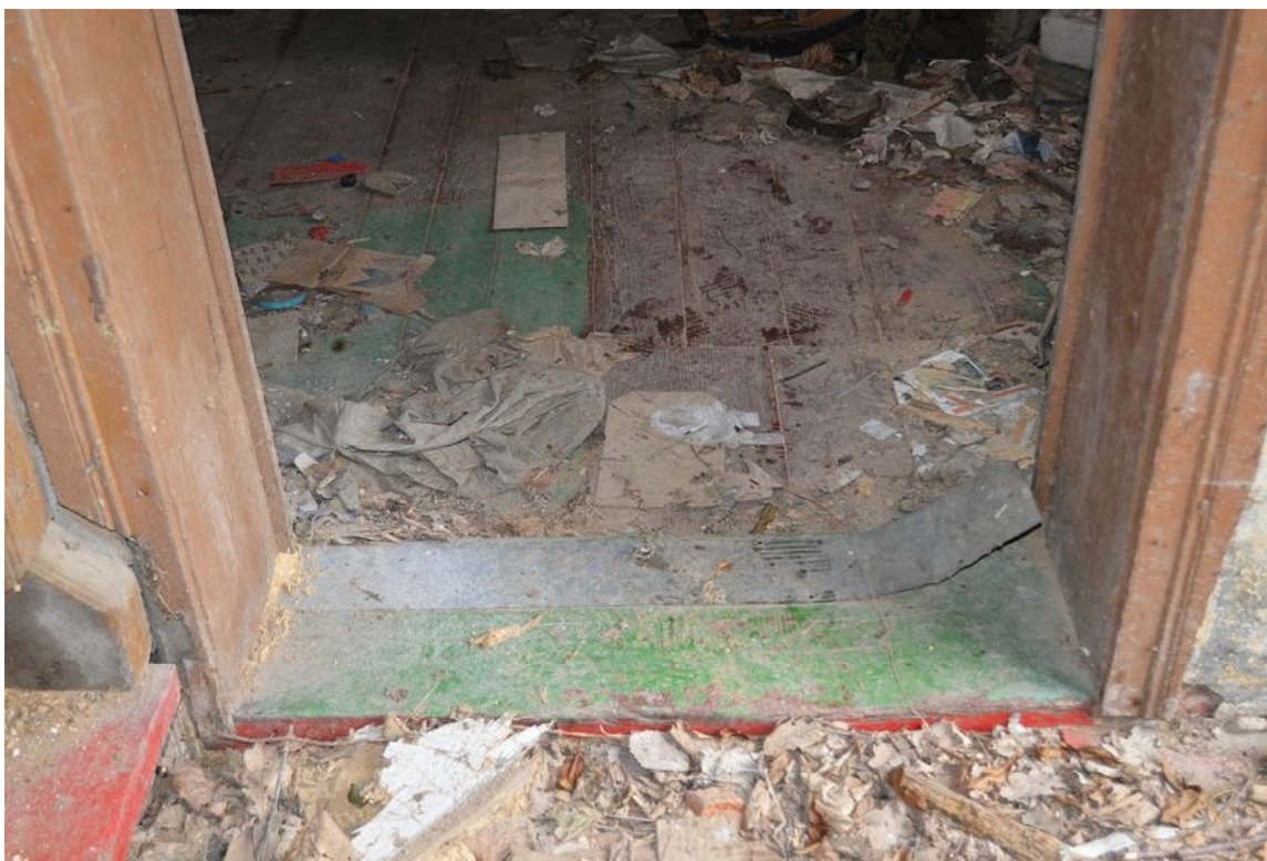
II. 121 Dusocin – Budynek mieszkalny w zabytkowej zagrodzie wiejskiej – stolarka drzwiowa - drzwi wewnętrzne TYP (D/5) – widok na próg i fragment ościeżyny z opaskami
