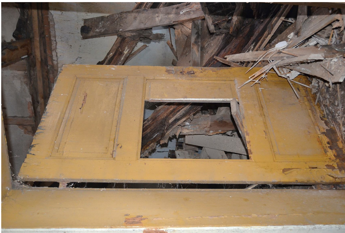
II. 126 Dusocin – Budynek mieszkalny w zabytkowej zagrodzie wiejskiej – stolarka drzwiowa - drzwi wewnętrzne TYP III – widok na pierwotne skrzydło drzwiowe (D/8)
