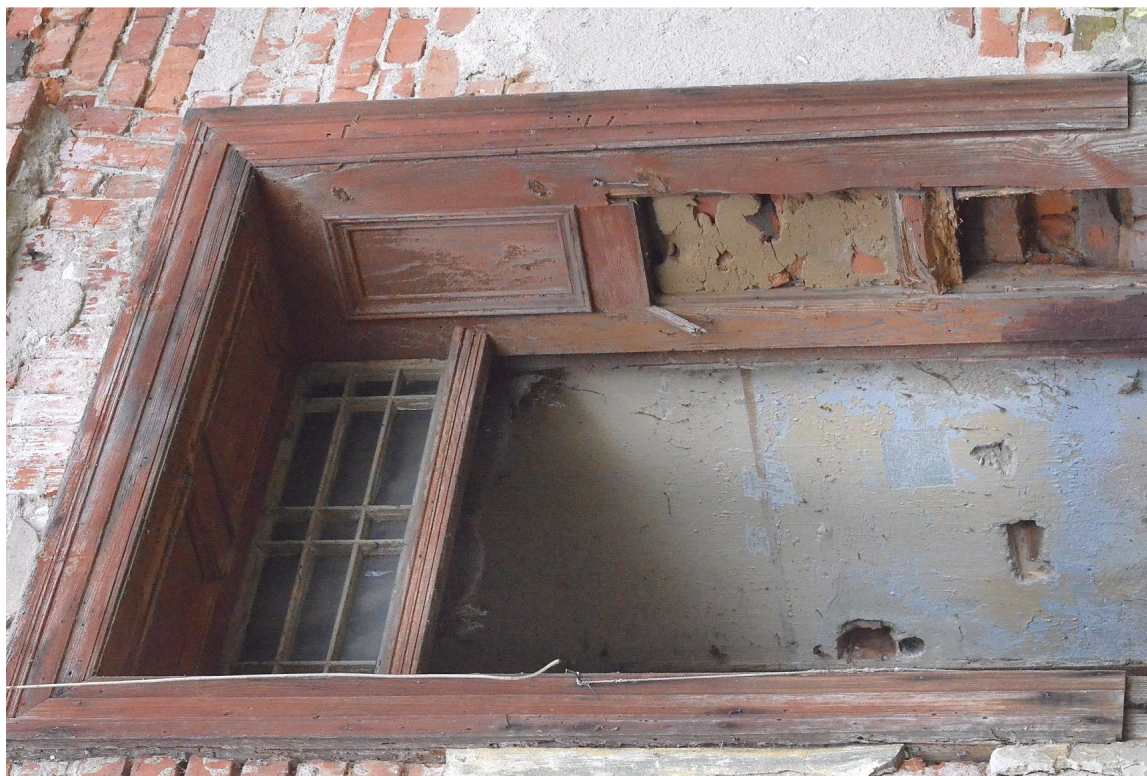
Il. 63 Dusocin – Budynek mieszkalny w zabytkowej zagrodzie wiejskiej – stolarka drzewiowa - drzwi wejściowe główne (D/1) – widok na ościeżinę ramowo-płycinową z profilowanymi opaskami
