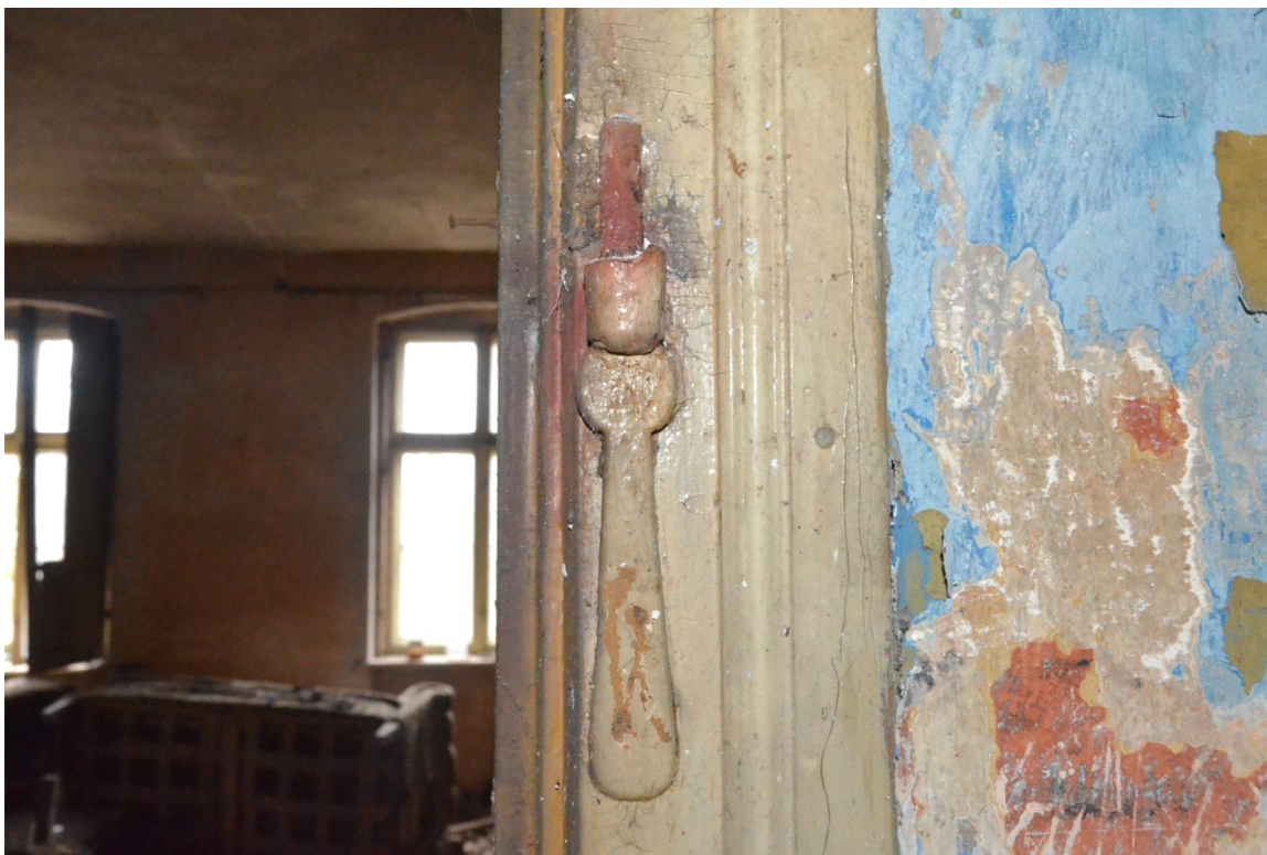
Il. 132 Dusocin – Budynek mieszkalny w zabytkowej zagrodzie wiejskiej – stolarka drzwiowa - drzwi wewnętrzne TYP III – widok na hak pierwotnego zawiasa hakowego tarczowego (D/13)
