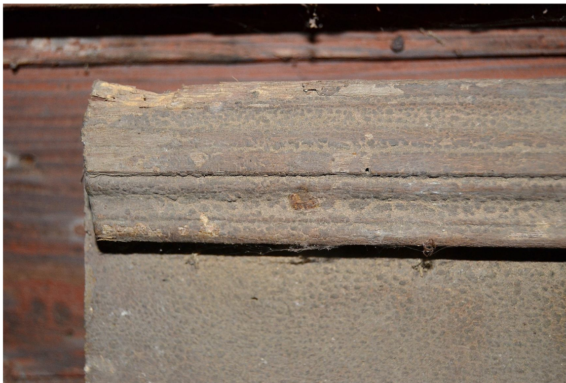
Il. 75 Dusocin – Budynek mieszkalny w zabytkowej zagrodzie wiejskiej – stolarka drzwiowa - drzwi wejściowe główne (D/1) – widok na fragment listwy przymykowej wewnętrznej fot. Ewa Bożejewicz 2018 r.
