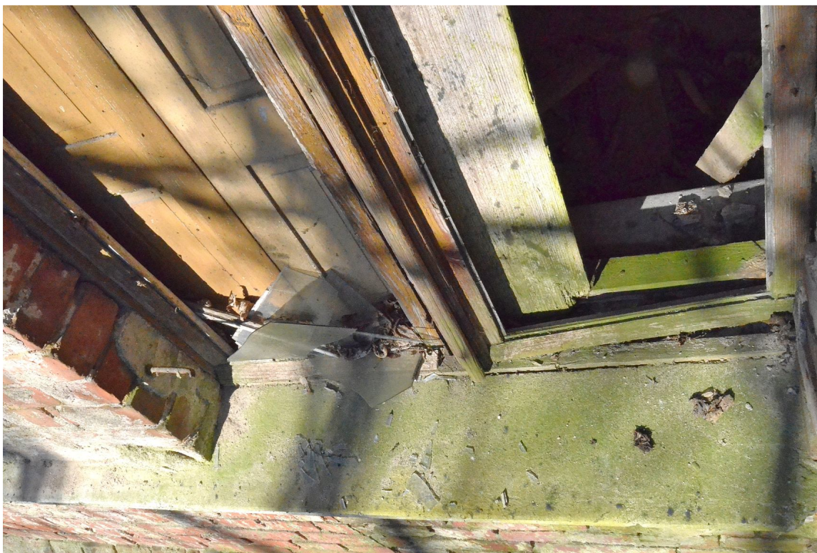
Il. 7 Dusocin – Budynek mieszkalny w zabytkowej zagrodzie wiejskiej – stolarka okienna - parter – widok na fragment pierwotnej stolarki okiennej oraz parapet zewnętrzny
