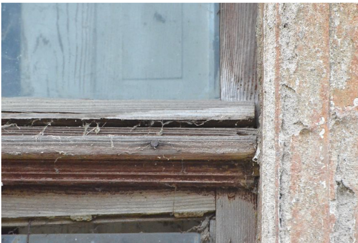
Il. 12 Dusocin – Budynek mieszkalny w zabytkowej zagrodzie wiejskiej – stolarka okienna - parter – widok na fragment śłemia pierwotnej stolarki okiennej fot. Ewa Bożejewicz 2018 r.
