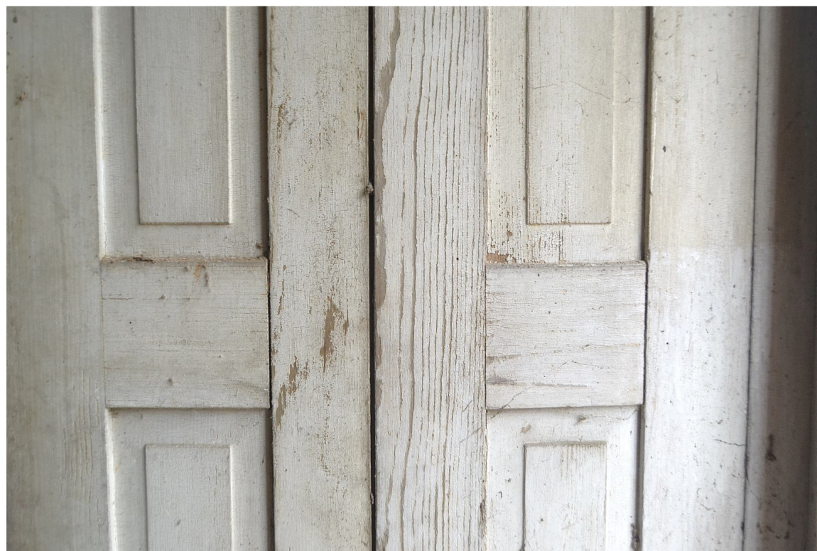
Il. 46 Dusocin – Budynek mieszkalny w zabytkowej zagrodzie wiejskiej – stolarka okienna - okiennice – widok na fragment okiennicy zachowanej w pomieszczeniu nr 3 fot. Ewa Bożejewicz 2018 r.
