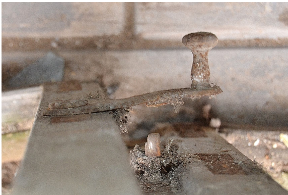
Il. 24 Dusocin – Budynek mieszkalny w zabytkowej zagrodzie wiejskiej – stolarka okienna - widok na fragment pierwotnej stolarki z zakrętką dźwigniową z hakiem i podkładką
