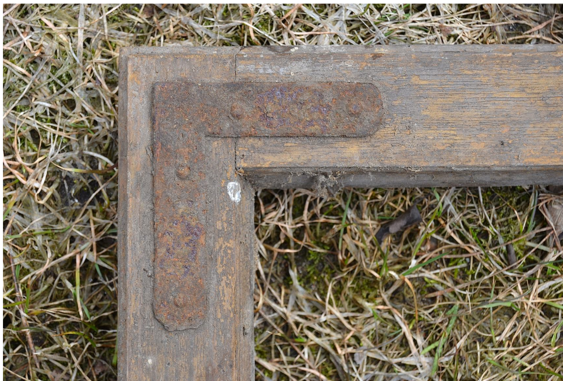
Il. 37 Dusocin – Budynek mieszkalny w zabytkowej zagrodzie wiejskiej – stolarka okienna - poddasze (ścianka kolankowa) – widok na fragment pierwotnego skrzydła z narożnikiem okiennym fot. Ewa Bożejewicz 2018 r.
