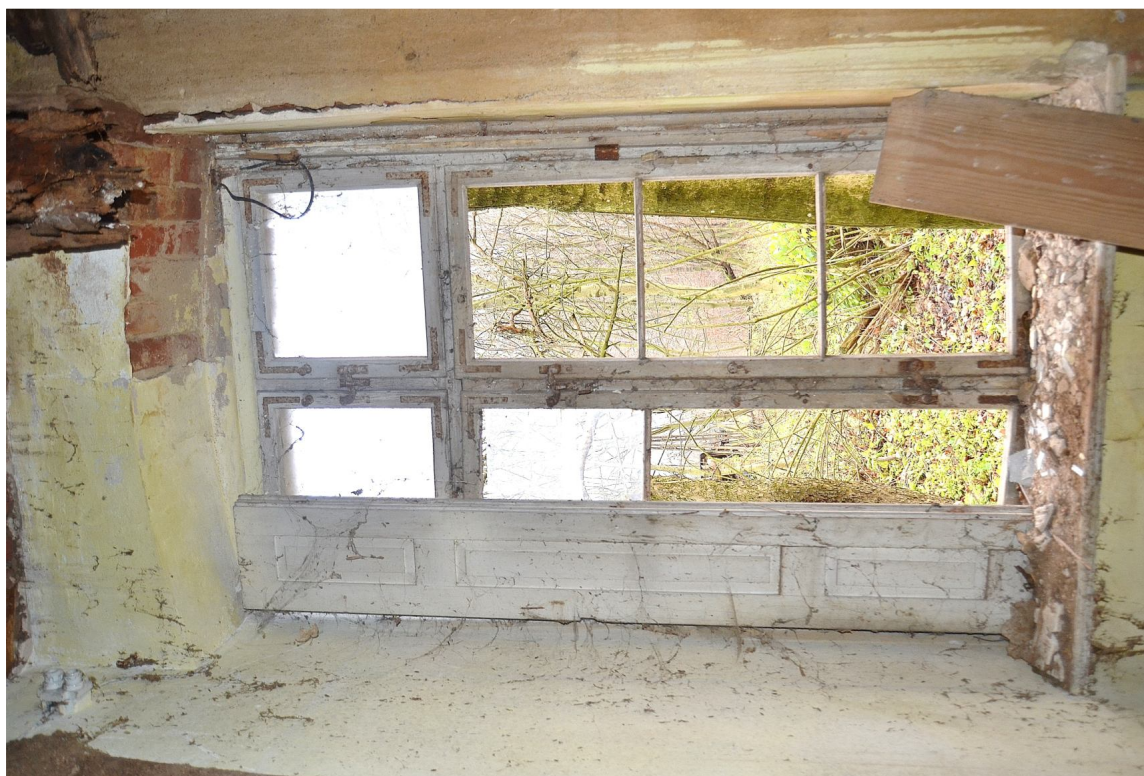
Il. 6 Dusocin – Budynek mieszkalny w zabytkowej zagrodzie wiejskiej – stolarka okienna - parter – widok na pierwotną stolarkę okienną krosnową z okiennicą wewnętrzną - rewers
