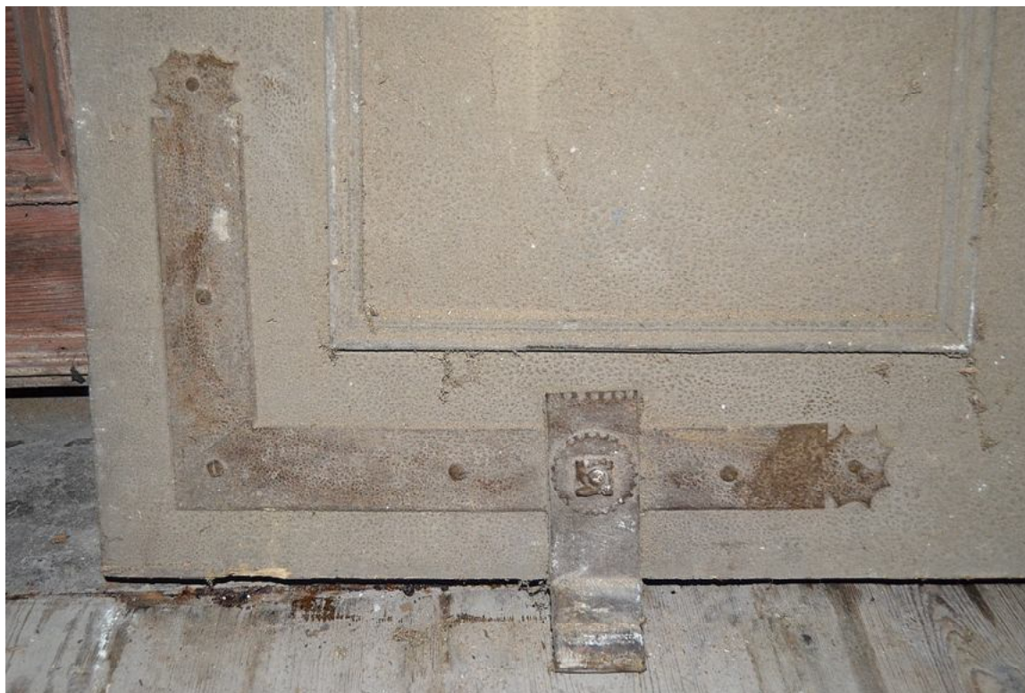
Il. 76 Dusocin – Budynek mieszkalny w zabytkowej zagrodzie wiejskiej – stolarka drzwiowa - drzwi wejściowe główne (D/1) – widok na zawias hakowy kątowy drzwi fot. Ewa Bożejewicz 2018 r.
