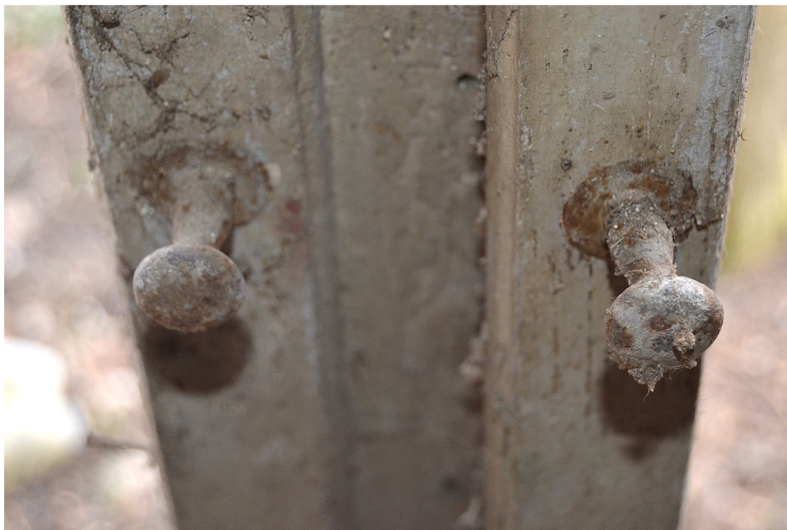
Il. 27 Dusocin – Budynek mieszkalny w zabytkowej zagrodzie wiejskiej – stolarka okienna - widok na pierwotne gałeczki okienne
