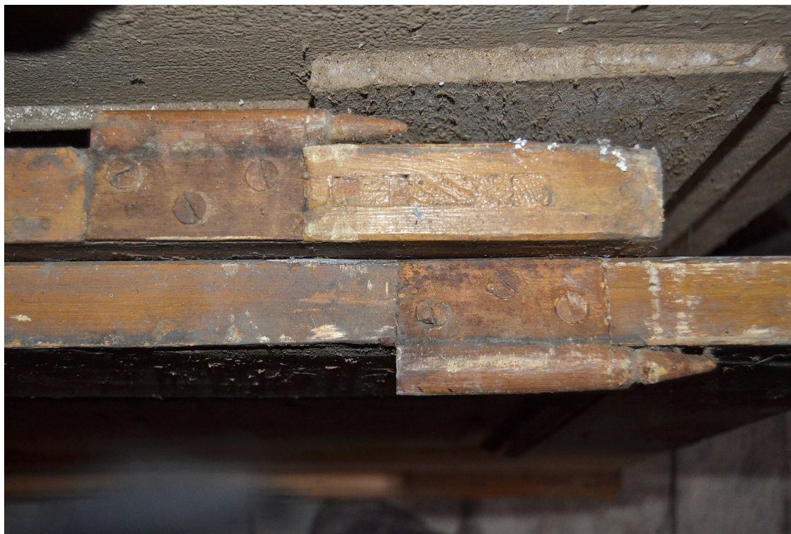
Il. 118 Dusocin – Budynek mieszkalny w zabytkowej zagrodzie wiejskiej – stolarka drzwiowa - drzwi wewnętrzne TYP I – widok na połączenie czopowe ramiaków oraz zawias czopowy nakładany fot. Ewa Bożejewicz 2018 r.
