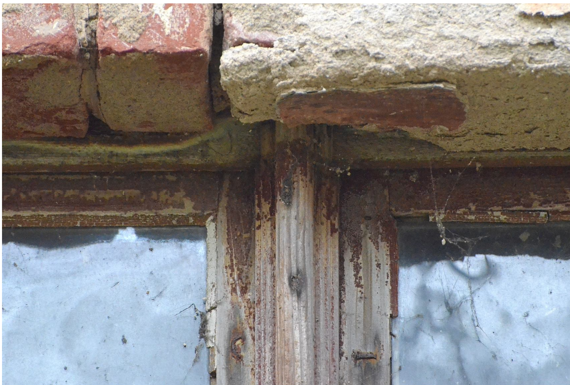
Il. 11 Dusocin – Budynek mieszkalny w zabytkowej zagrodzie wiejskiej – stolarka okienna - parter – widok na górny odcinek słupka pierwotnej stolarki okiennej, wprowadzony w nadproże fot. Ewa Bożejewicz 2018 r.
