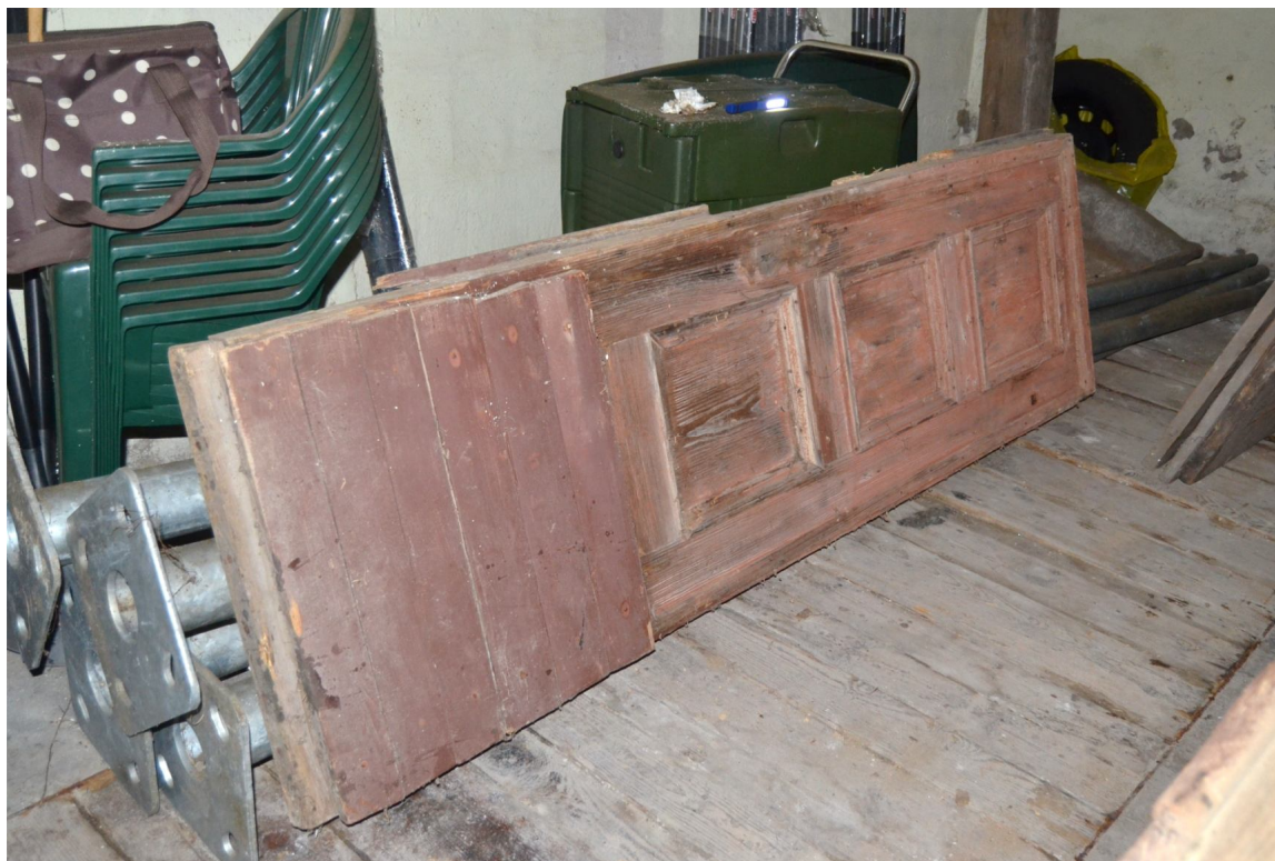
Il. 68 Dusocin – Budynek mieszkalny w zabytkowej zagrodzie wiejskiej – stolarka drzwiowa - drzwi wejściowe główne (D/1) – widok na skrzydło drzwiowe lewe
