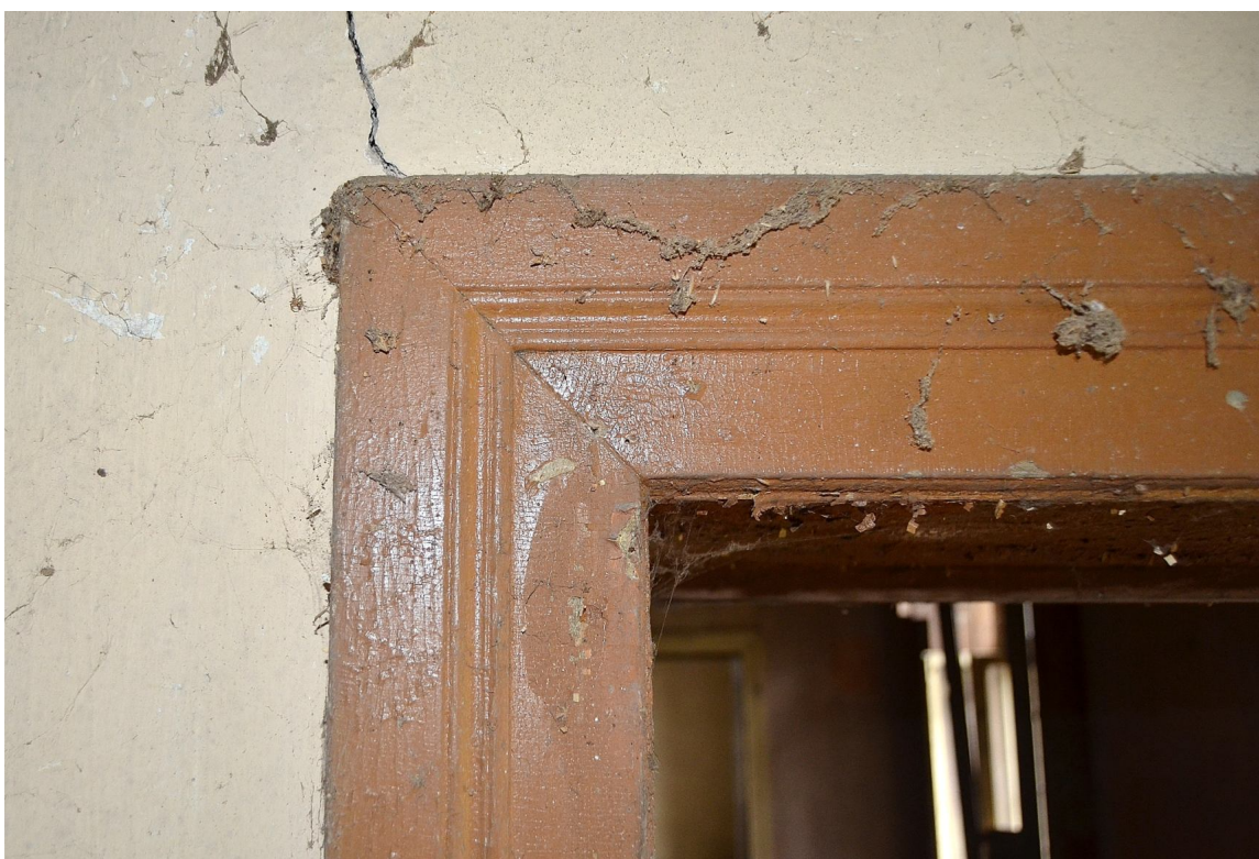
II. 122 Dusocin – Budynek mieszkalny w zabytkowej zagrodzie wiejskiej – stolarka drzwiowa - drzwi wewnętrzne TYP (D/5) – widok na fragment opaski drzwiowej
