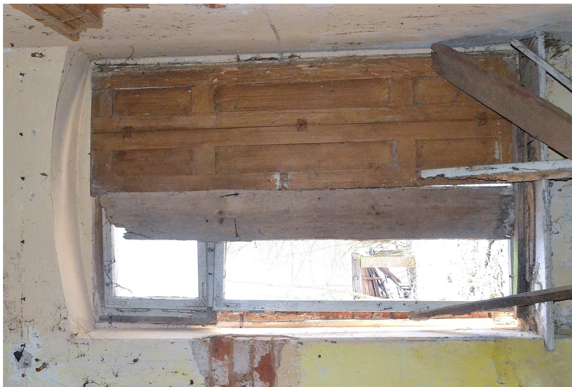
Il. 41 Dusocin – Budynek mieszkalny w zabytkowej zagrodzie wiejskiej – stolarka okienna - okiennice – widok na okiennicę wewnętrzną zachowaną w oknie sieni
