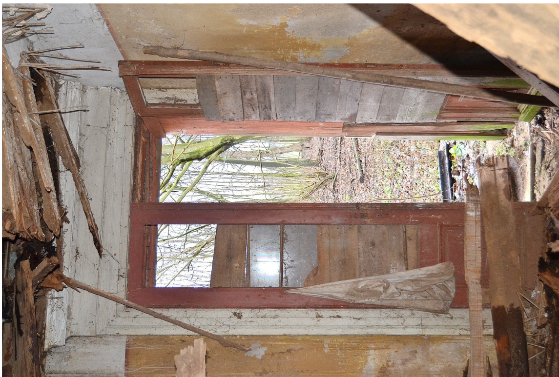
II. 100 Dusocin – Budynek mieszkalny w zabytkowej zagrodzie wiejskiej – stolarka drzwiowa - drzwi wejściowe tylne (D/3) – rewers
