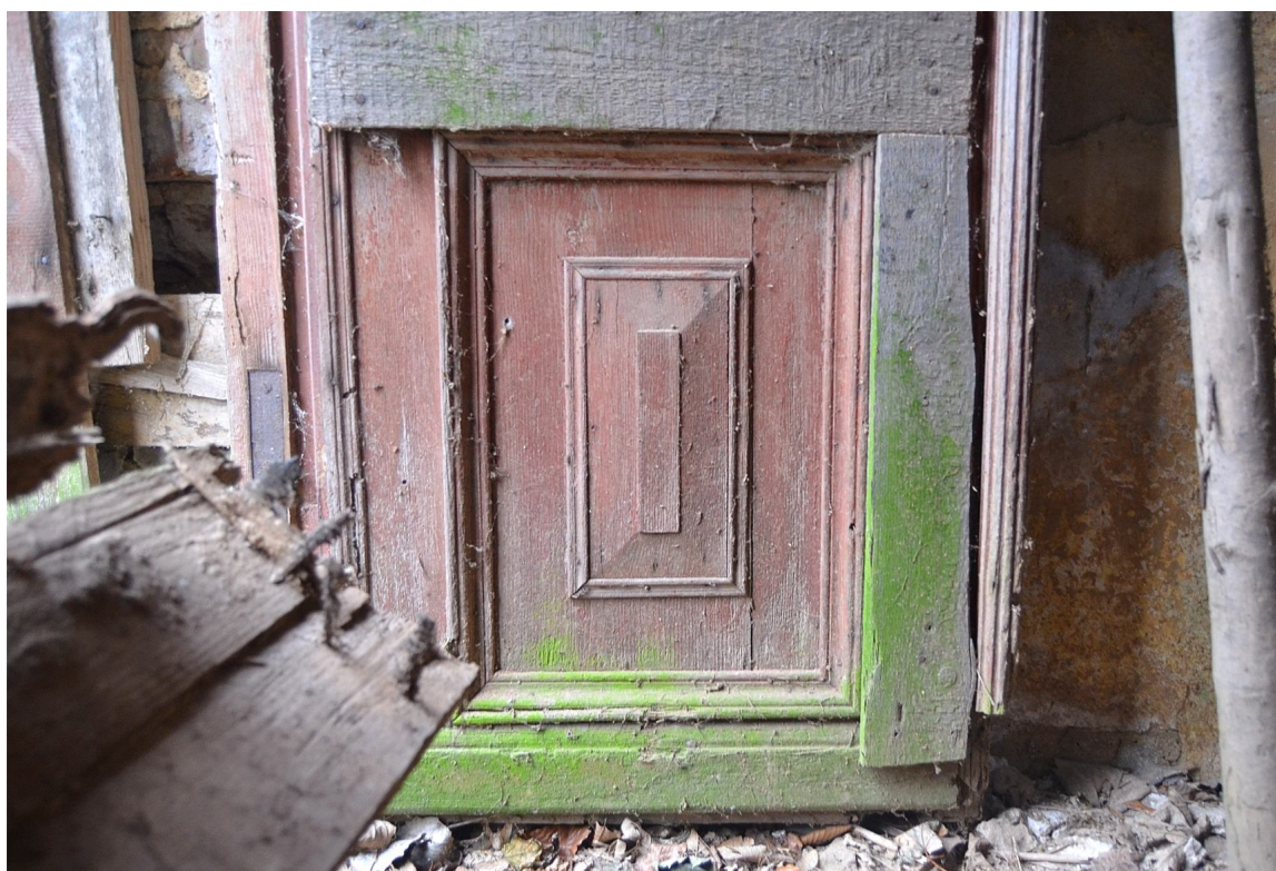
Il. 102 Dusocin – Budynek mieszkalny w zabytkowej zagrodzie wiejskiej – stolarka drzwiowa - drzwi wejściowe tylne (D/3) - widok na dolną część skrzydła drzwiowego – awers
