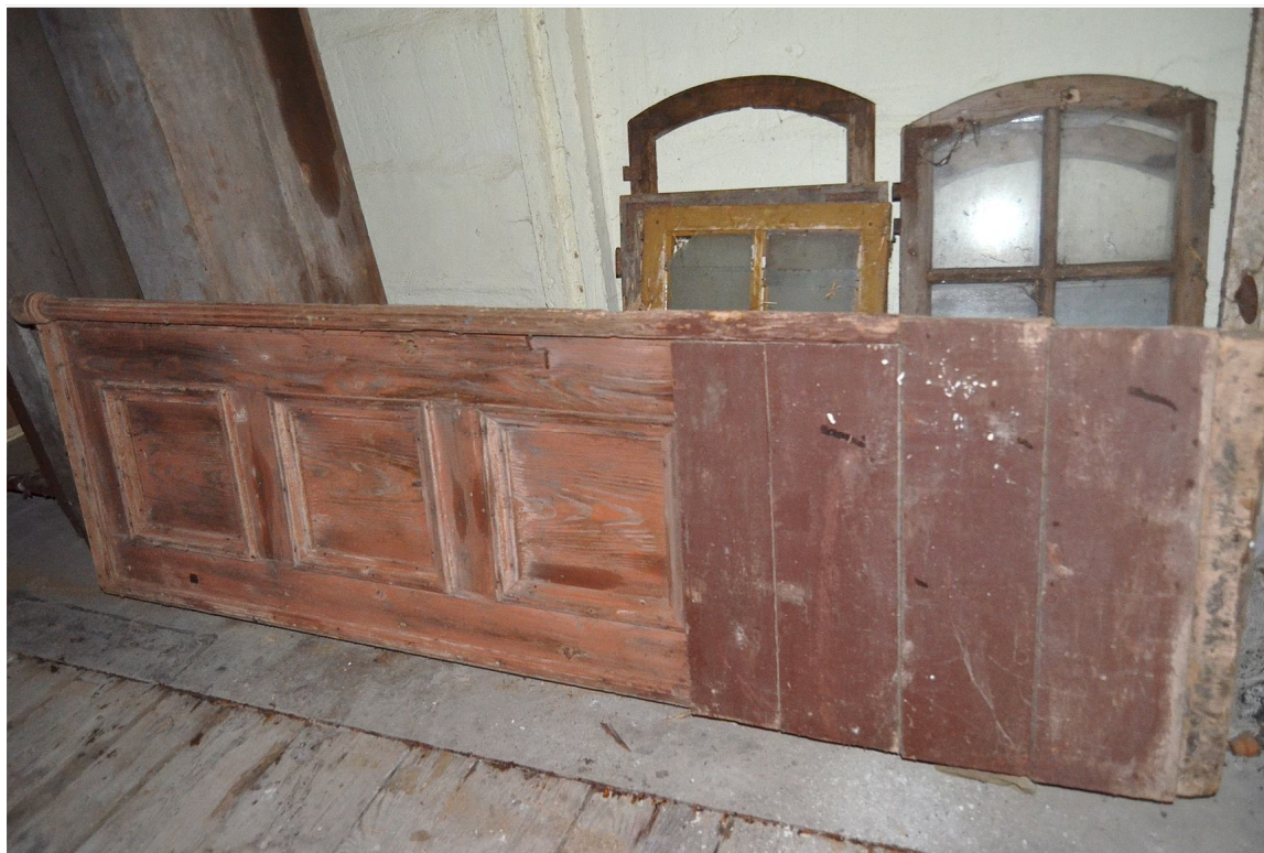
Il. 67 Dusocin – Budynek mieszkalny w zabytkowej zagrodzie wiejskiej – stolarka drzwiowa - drzwi wejściowe główne (D/1) – widok na skrzydło drzwiowe prawe
