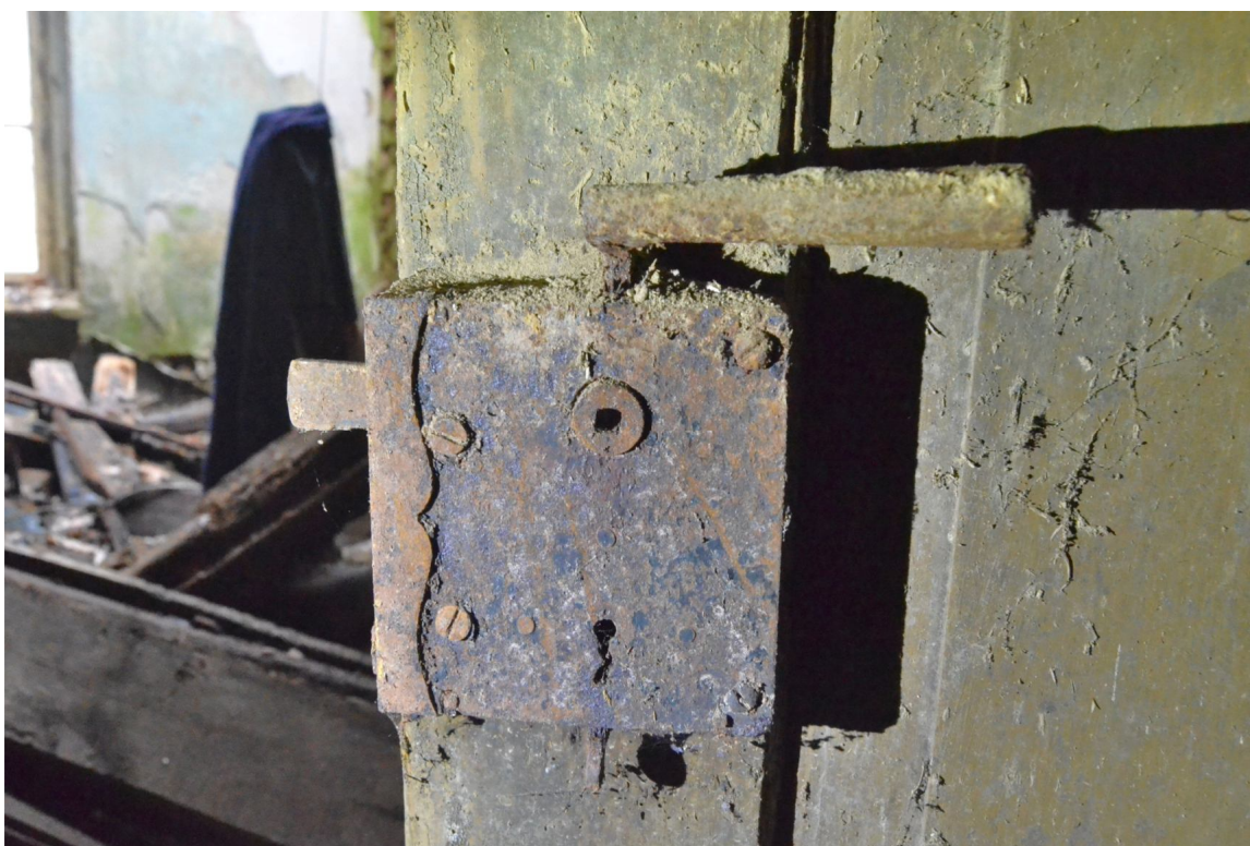
Il. 128 Dusocin – Budynek mieszkalny w zabytkowej zagrodzie wiejskiej – stolarka drzwiowa - drzwi wewnętrzne TYP (D/6) – widok na pierwotny zamek skrzynkowy
