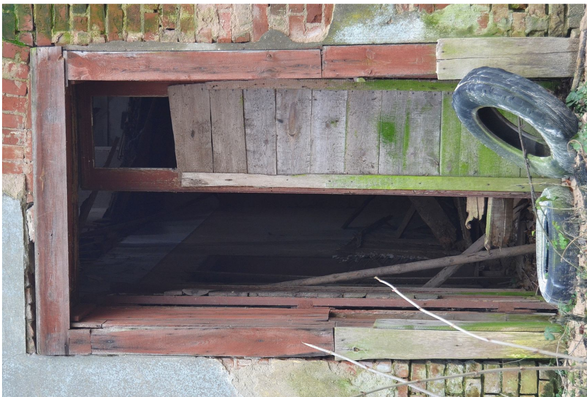
II. 99 Dusocin – Budynek mieszkalny w zabytkowej zagrodzie wiejskiej – stolarka drzwiowa - drzwi wejściowe tylne (D/3) – awers
