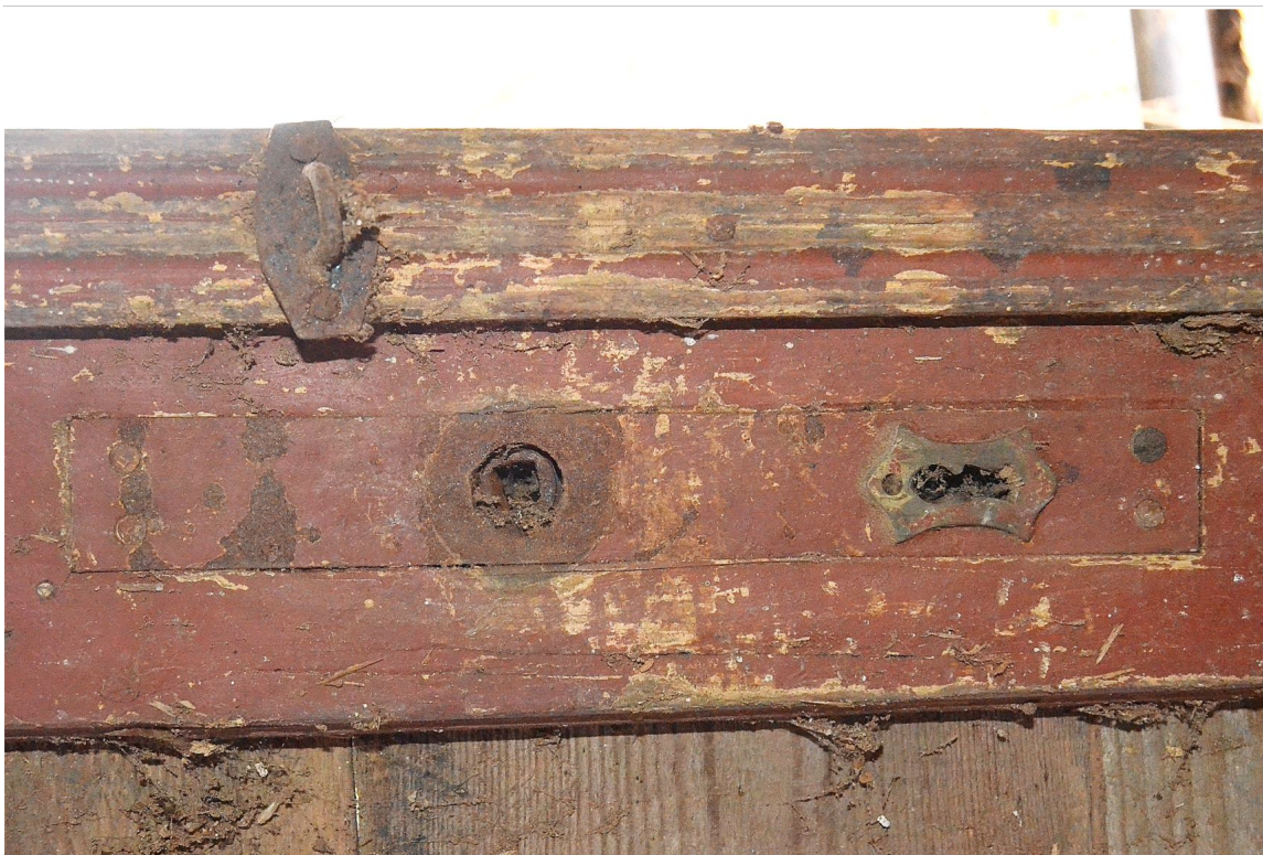
II. 106 Dusocin – Budynek mieszkalny w zabytkowej zagrodzie wiejskiej – stolarka drzwiowa - drzwi wejściowe tylne (D/3) – widok na szyld pierwotnej klamki drzwiowej
