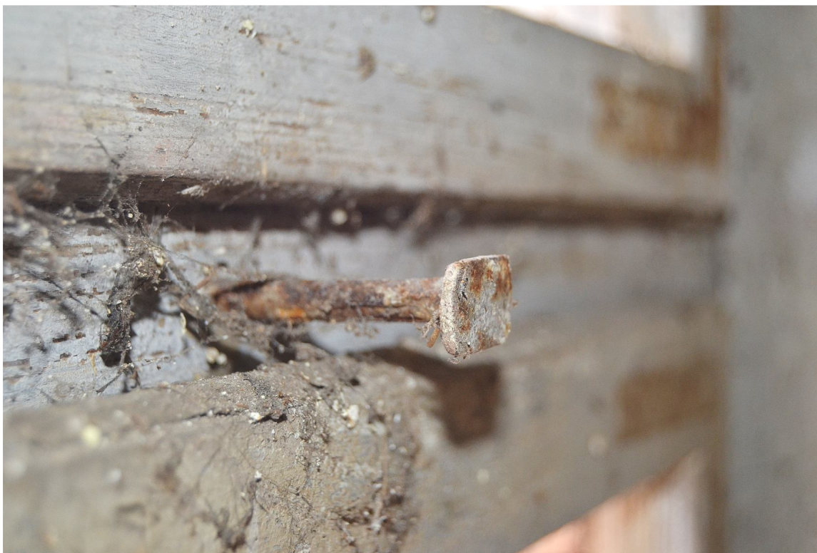
Il. 55 Dusocin – Budynek mieszkalny w zabytkowej zagrodzie wiejskiej – stolarka okienna - okiennice – widok na odbój okiennicy, zamontowany w ślemieniu okna
