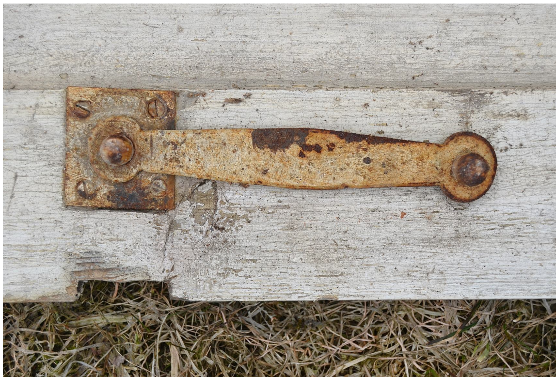
Il. 53 Dusocin – Budynek mieszkalny w zabytkowej zagrodzie wiejskiej – stolarka okienna - okiennice – widok na pierwotną zakrętkę dźwigniową okiennicy
