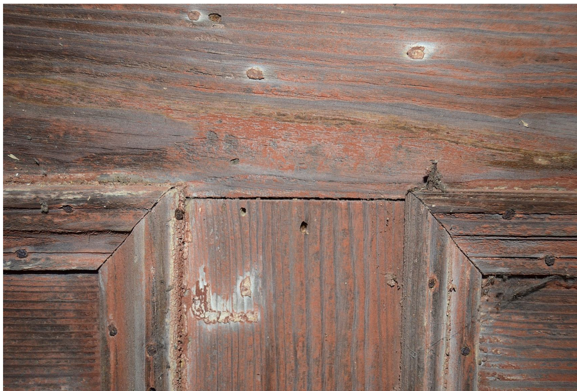
Il. 69 Dusocin – Budynek mieszkalny w zabytkowej zagrodzie wiejskiej – stolarka drzwiowa - drzwi wejściowe główne (D/1) – widok na fragment skrzydła drzwiowego
