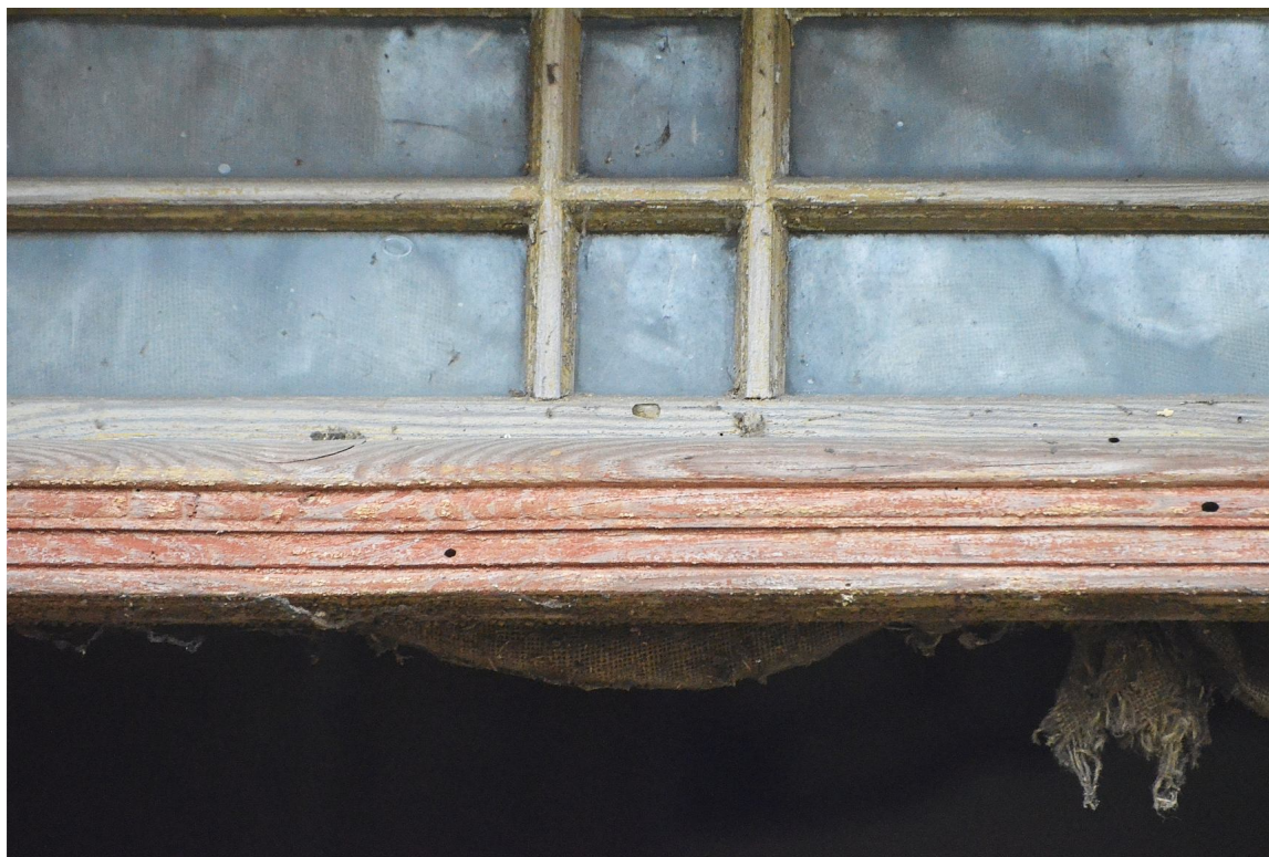
Il. 62 Dusocin – Budynek mieszkalny w zabytkowej zagrodzie wiejskiej – stolarka drzewiowa - drzwi wejściowe główne (D/1) – widok na fragment ślemienia i skrzydła nadświetla
