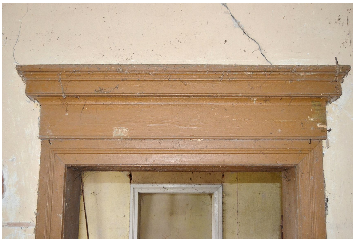
II. 120 Dusocin – Budynek mieszkalny w zabytkowej zagrodzie wiejskiej – stolarka drzwiowa - drzwi wewnętrzne TYP II – widok na fragment ościeżyny z przyczółkiem (D/4) fot. Ewa Bożejewicz 2018 r.
