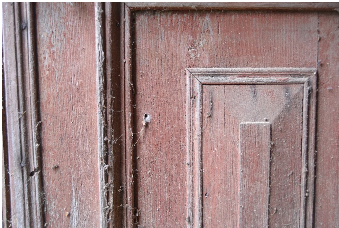
Il. 103 Dusocin – Budynek mieszkalny w zabytkowej zagrodzie wiejskiej – stolarka drzwiowa - drzwi wejściowe tylne (D/3) – widok na fragment dolnej płyciny z lustrem skrzydła drzwiowego fot. Ewa Bożejewicz 2018 r.
