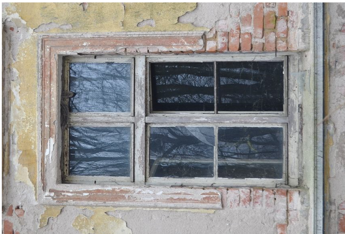
Il. 29 Dusocin – Budynek mieszkalny w zabytkowej zagrodzie wiejskiej – stolarka okienna - parter – widok na wtórną stolarkę okienną skrzynkową jednokrosnową - awers
