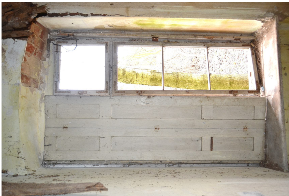
Il. 5 Dusocin – Budynek mieszkalny w zabytkowej zagrodzie wiejskiej – stolarka okienna - parter – widok na pierwotną stolarkę okienną krosnową z okiennicą wewnętrzną - rewers
